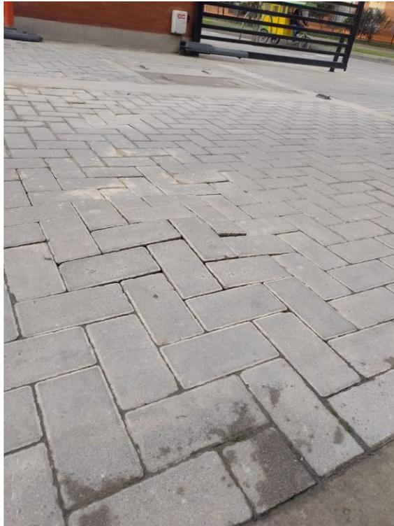
*Foto 6. Adoquín circulación vehicular suelto*
