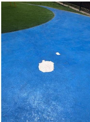
Foto 29. Levantamiento de acabado de piso
