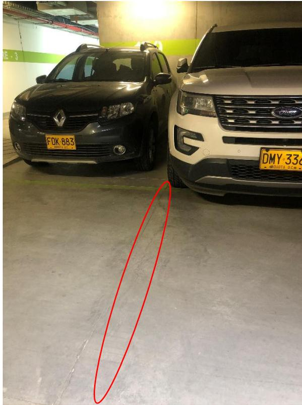
*Foto 74. Fisura en placa de piso en circulación frente al parqueadero 139*
