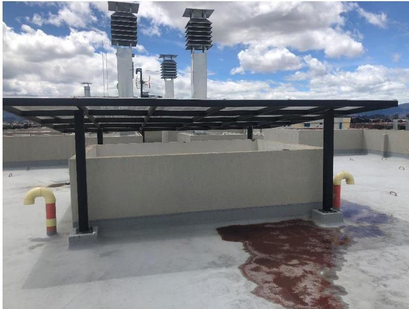
*Foto 106. Empozamientos de agua en cubierta*
