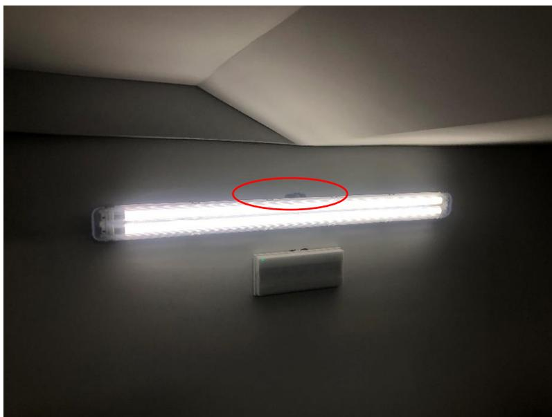
*Foto 100. Rematar hueco en pared sobre lampara PLANTA 6*
