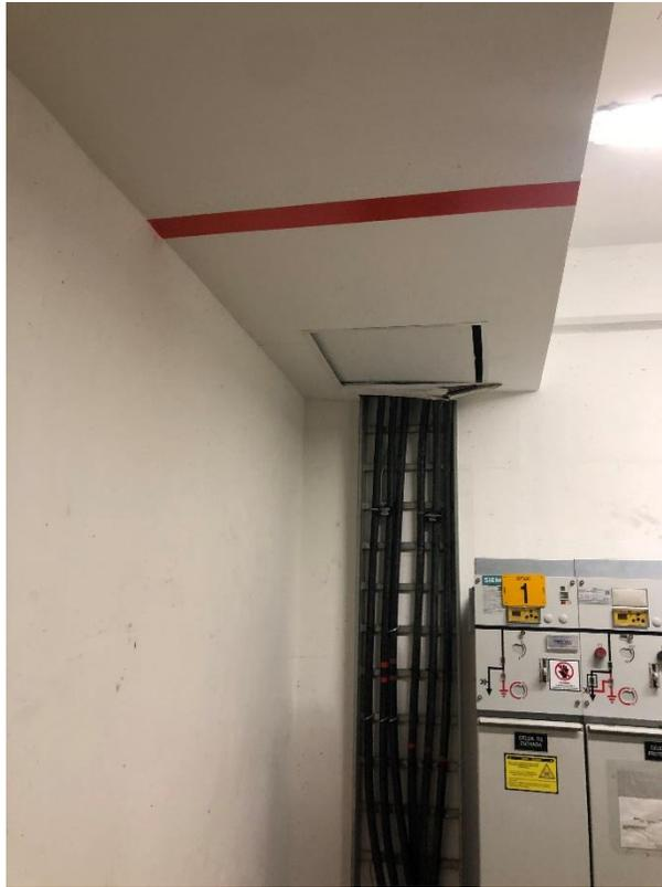
*Foto 68. Cielo raso- Tapa de inspección*
