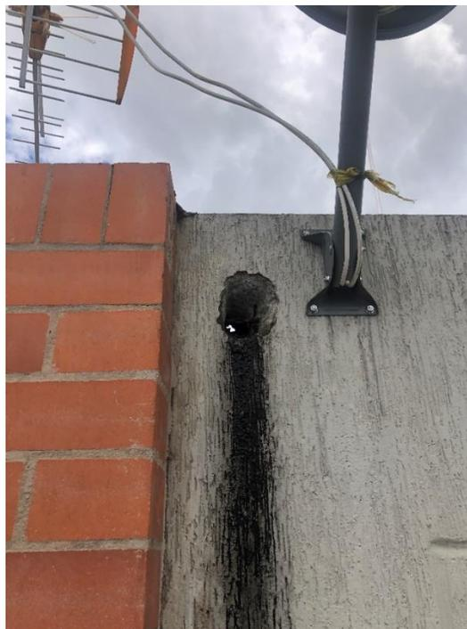
*Foto 161. Desagüe cubierta de ascensor*
