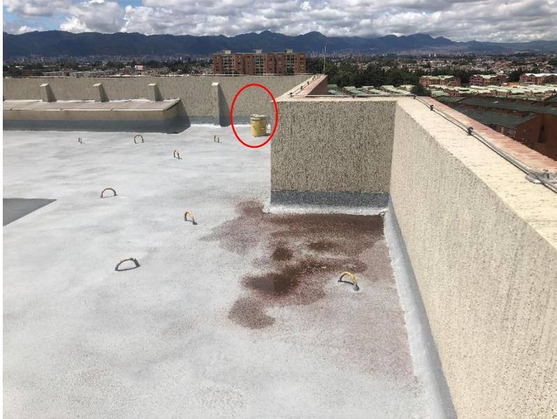
*Foto 78. Empozamientos de agua en cubierta y materiales de construcción*
