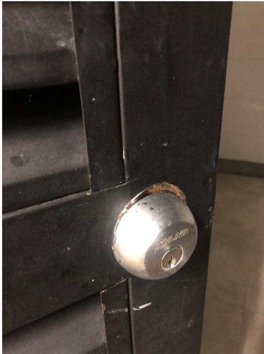
*Foto 63. Cerradura suelta y oxido en puerta Torre 5 cuarto de basuras*
