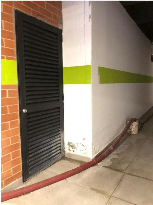
*Foto 52. Humedad en muros de cuarto de bombas*
