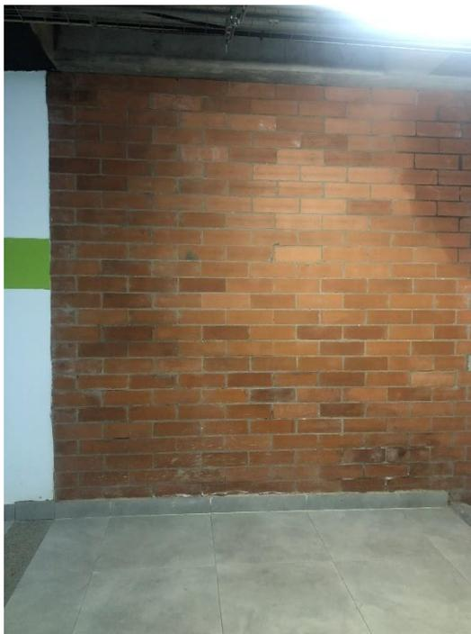
*Foto 41. Humedad en muro hacia la torre 2, al lado de escaleras*
