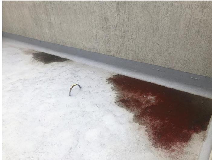
*Foto 138. Empozamientos de Agua en cubierta*
