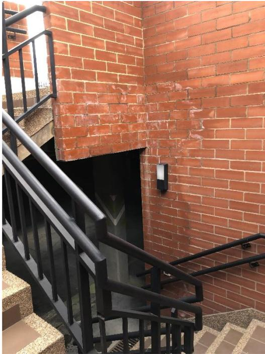
*Foto 2. Muros Escalera con humedad salida hacia el parqueadero V-22*
