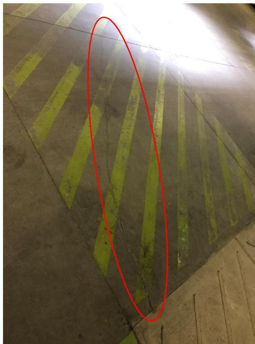
*Foto 73. Fisura en placa de piso frente al hall hacia torre 3*
