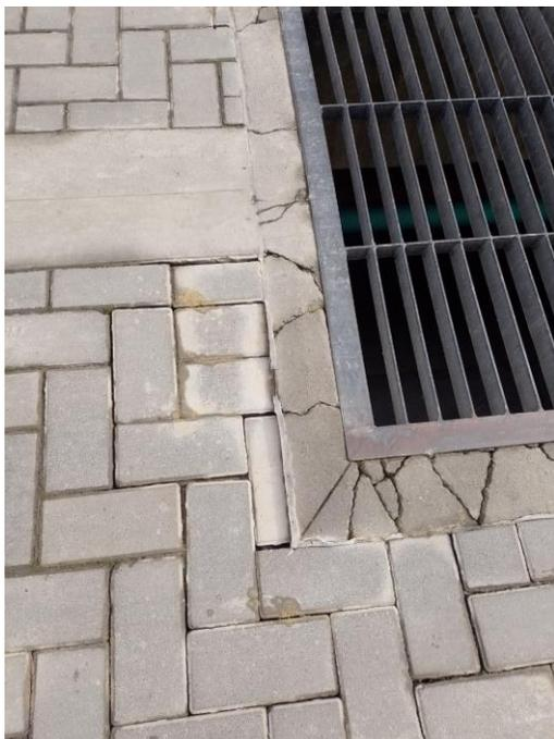
*Foto 10. marco de las rejillas en circulación de parqueadero fisurado*
