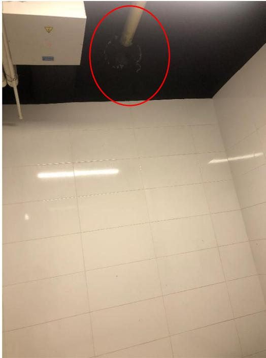
*Foto 62. Humedad al contorno de la tubería en cuarto de basuras torre 5*
