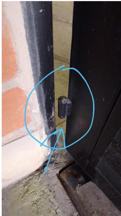
*Foto 65. Bisagra suelta en el parte inferior cuarto de basuras pp*
