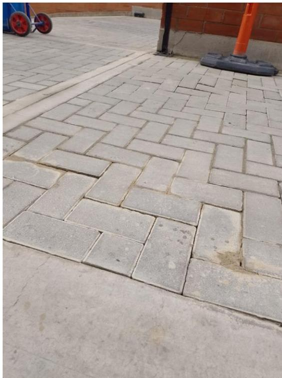
*Foto 7. Adoquín circulación vehicular suelto*
