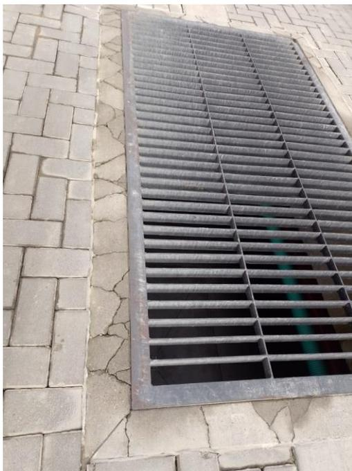
*Foto 11. marco de las rejillas en circulación de parqueadero fisurado*
