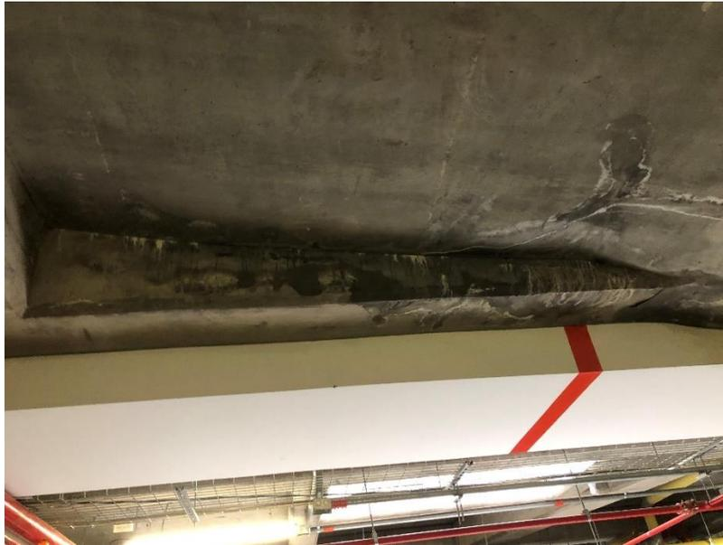
*Foto 36. Humedad por filtración desde P1-rampa*
