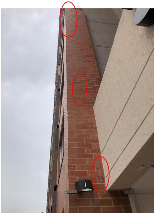
Foto 135. Foto 128. huecos en general en mortero de muros exteriores
