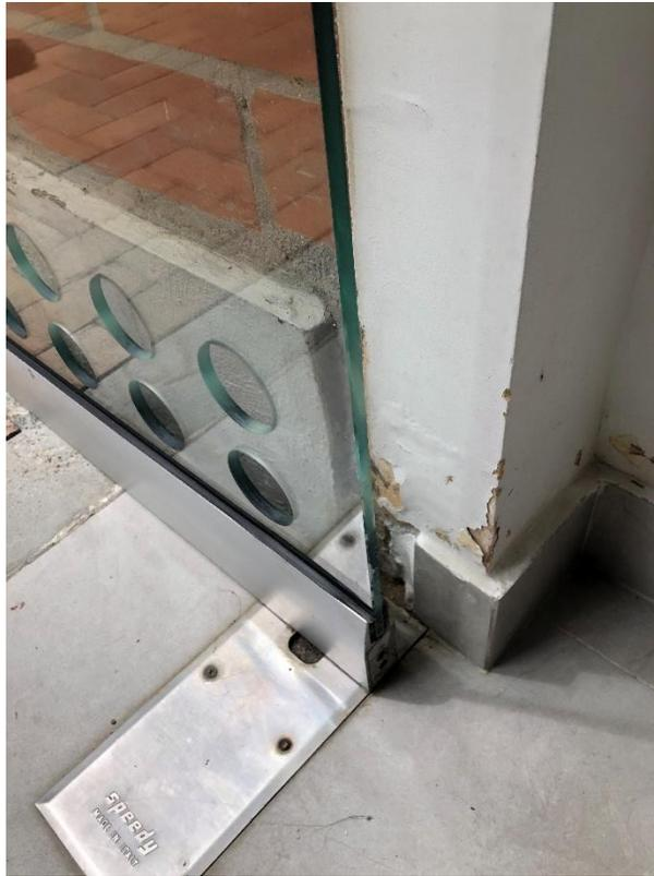
*Foto 181. Humedad en muro inferior al ingreso de la torre*
