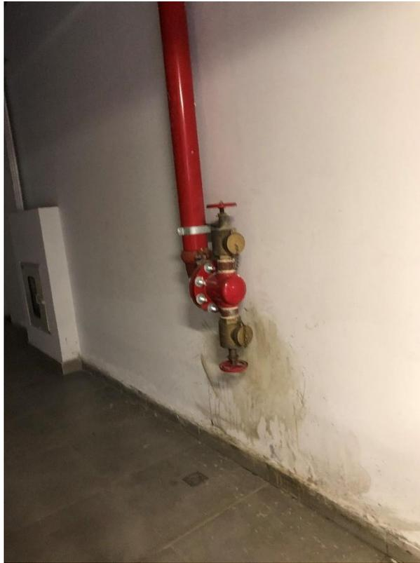
*Foto 53. Humedad en muro frente a cuarto de bombas*
