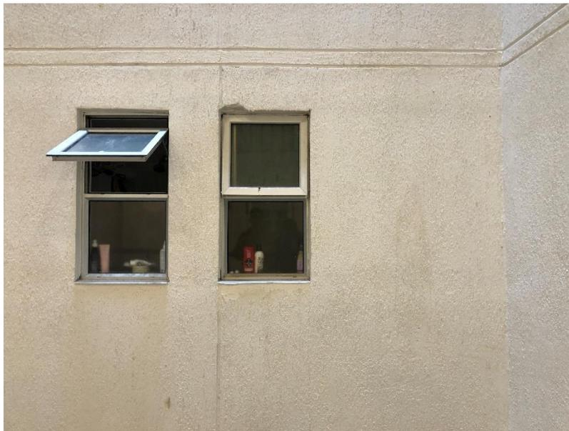
Foto 131. Rematar vano de ventana desportillado en vacío
