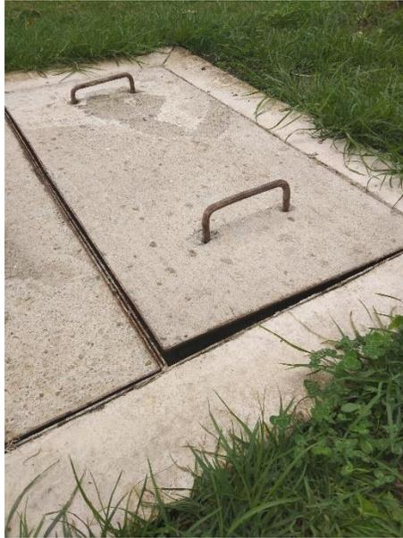
*Foto 14. Tapas de inspección no cierran correctamente*
