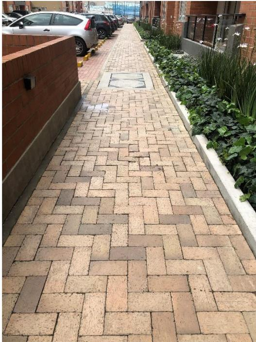
*Foto 12. Adoquín circulación peatonal frente a torre 5 suelto*
