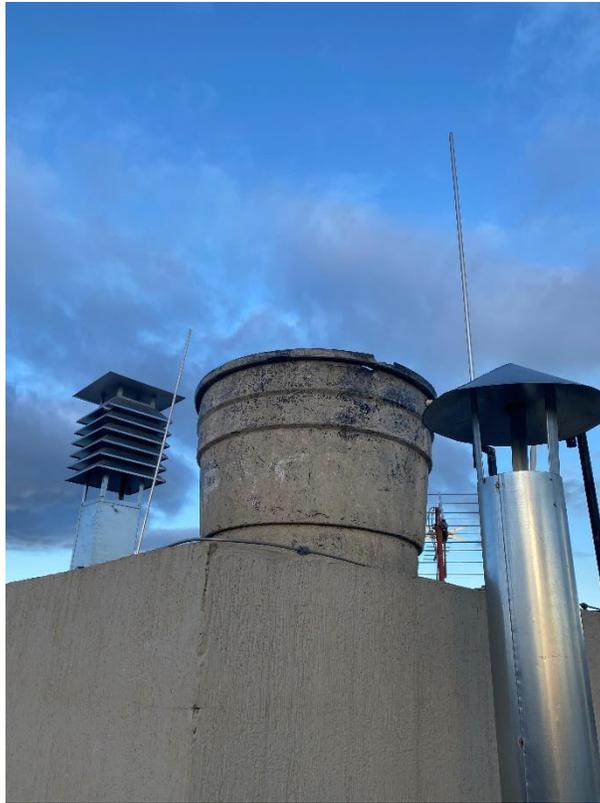
*Foto 126. tanque de agua sobre cubierta del ascensor*
