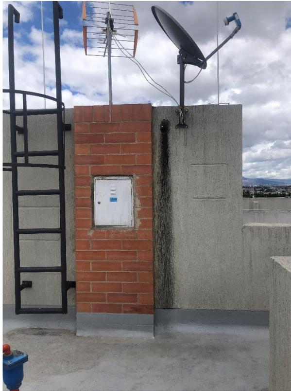
*Foto 160. desagüe de cubierta de ascensor*
