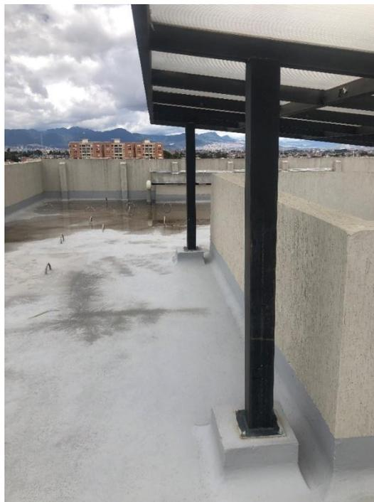
*Foto 167. empozamiento de agua en cubierta*
