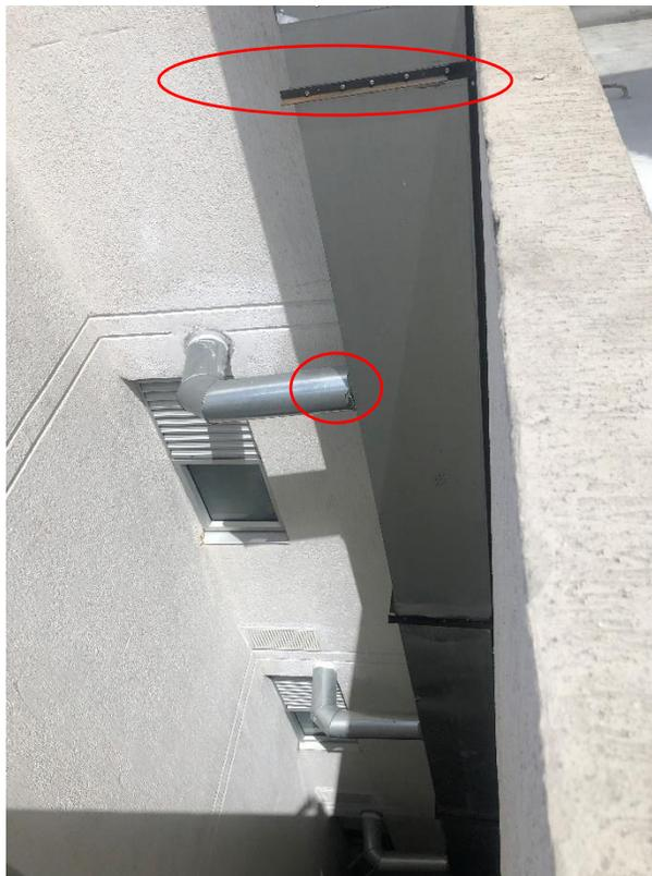
Foto 115. Verificar uniones de ducto y perfiles oxidados
