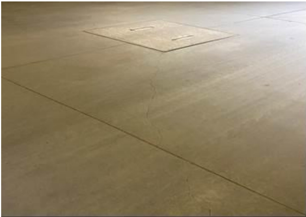
Foto 33 Fisura en placa de contrapiso parqueadero 233
