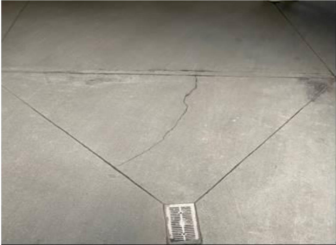
Foto 39 Fisura en placa de contrapiso frente parqueadero 149
