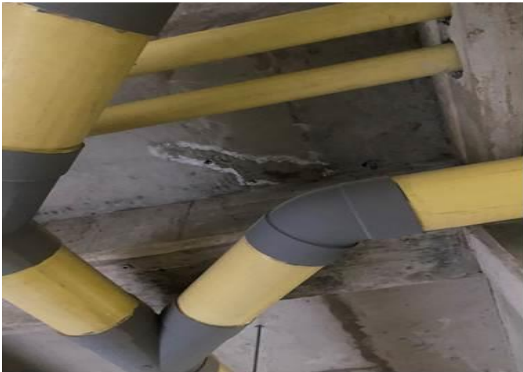
Foto 51 Ingreso de agua por fisura entre placa y viga torre 2
