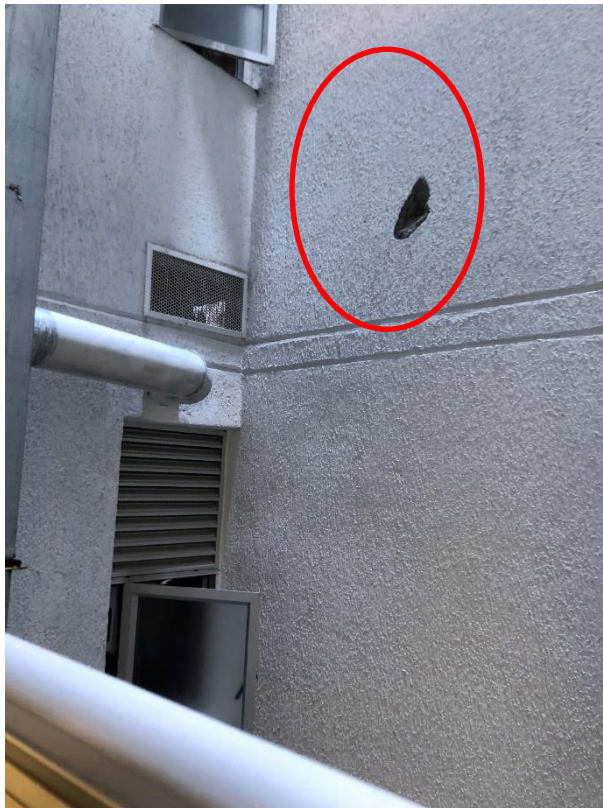
Foto 150. hueco en pared de vacío planta 6
