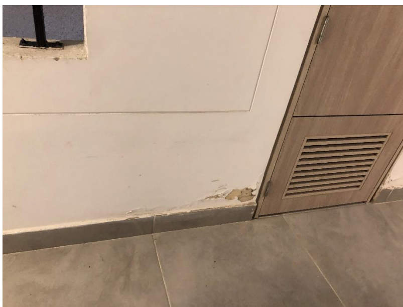
Foto 156. verificar humedad al lado de medidores apto 103
