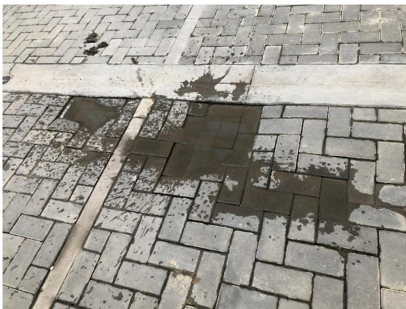
Foto 9. Hundimiento de Adoquin
