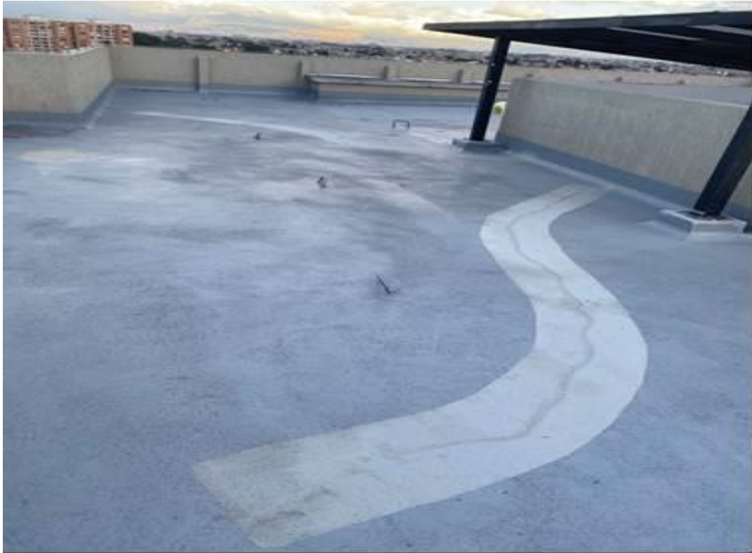
Foto 64 fisuras en placa cubiertas ya reparadas
