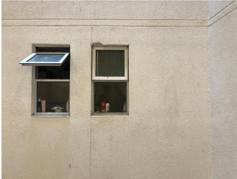
Foto 131. Rematar vano de ventana desportillado en vacío
