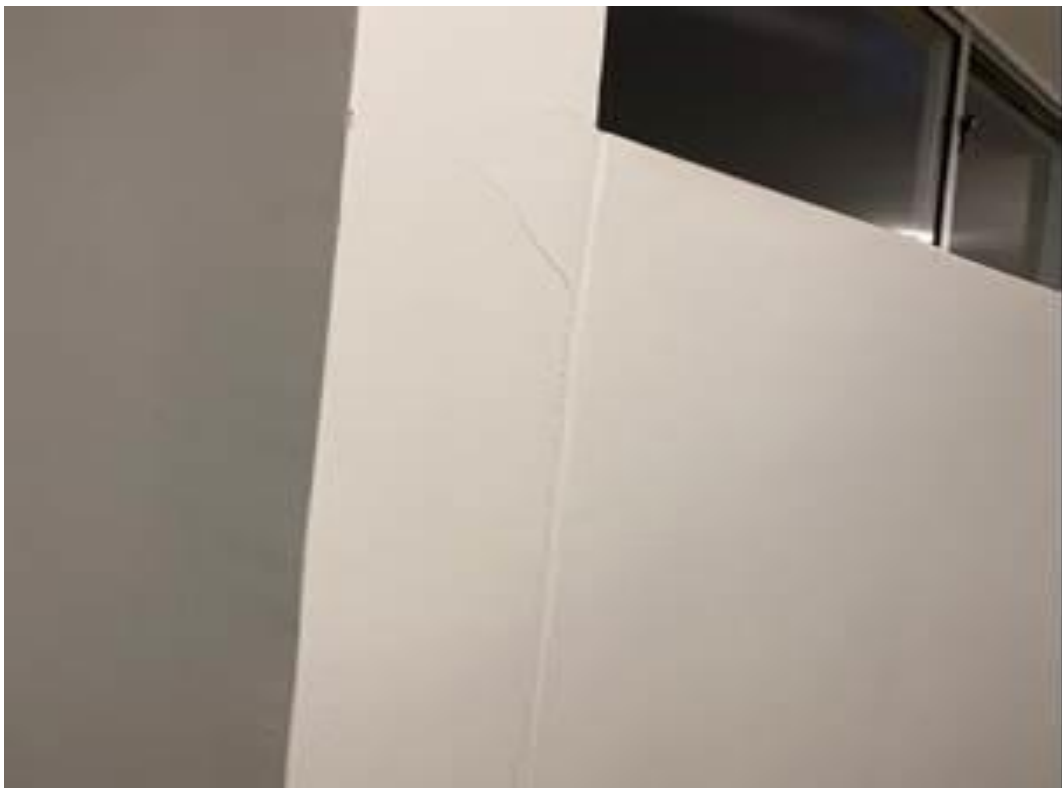
Foto 11 Fisuras en zona común torre 4 y 5 pisos 12 a 2
