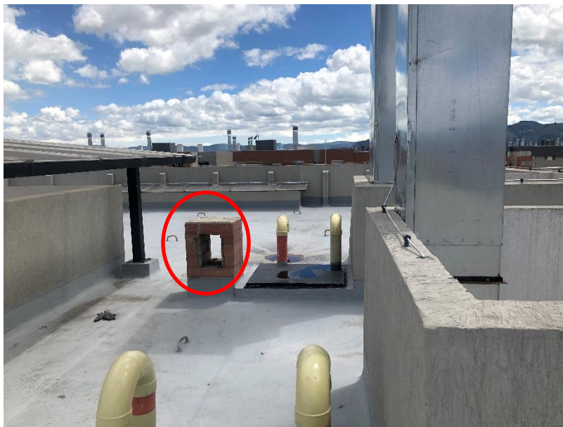
Foto 107. rematar muertes e instalar rejilla
