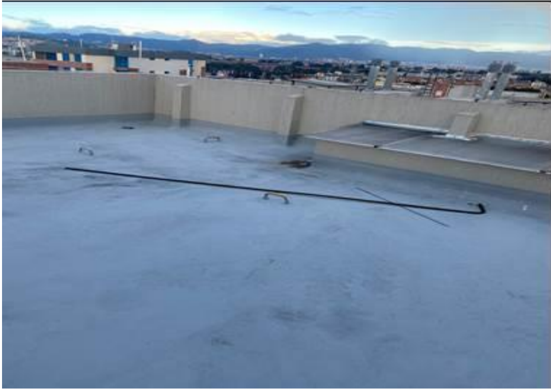
Foto 84 Marquesina perimetral y residuos de construcción en cubierta torres 2 y 3
