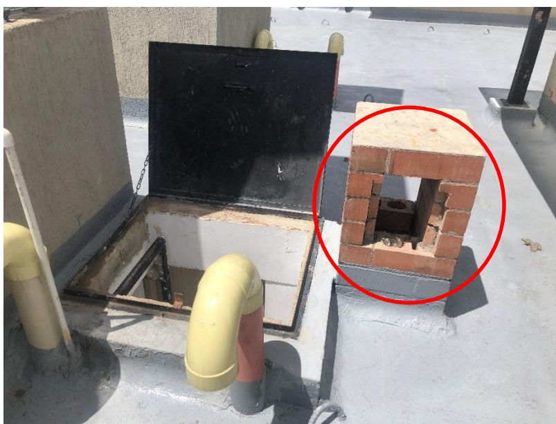
Foto 83.terminar acabados de muretes, falta rejilla
