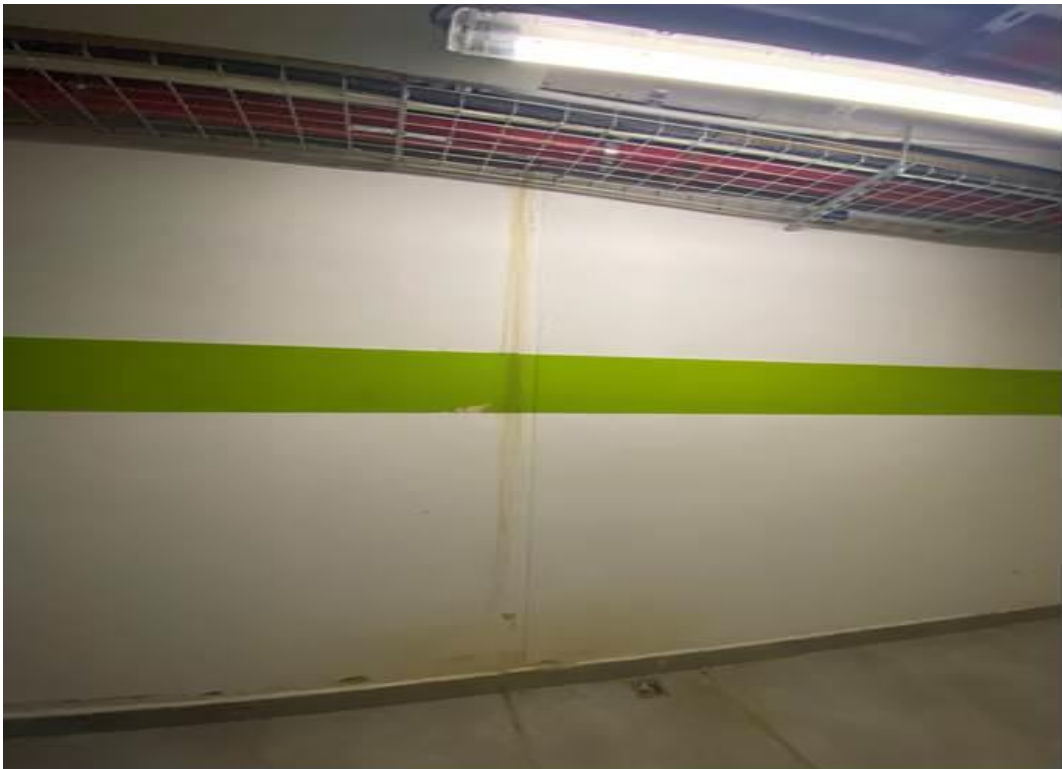
Foto 20 Filtraciones por fisuras muro de contención sótano
