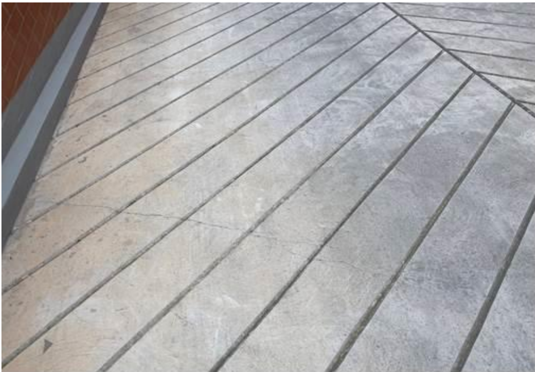
Foto 45 Adoquín este presentado deterioro prematuro
