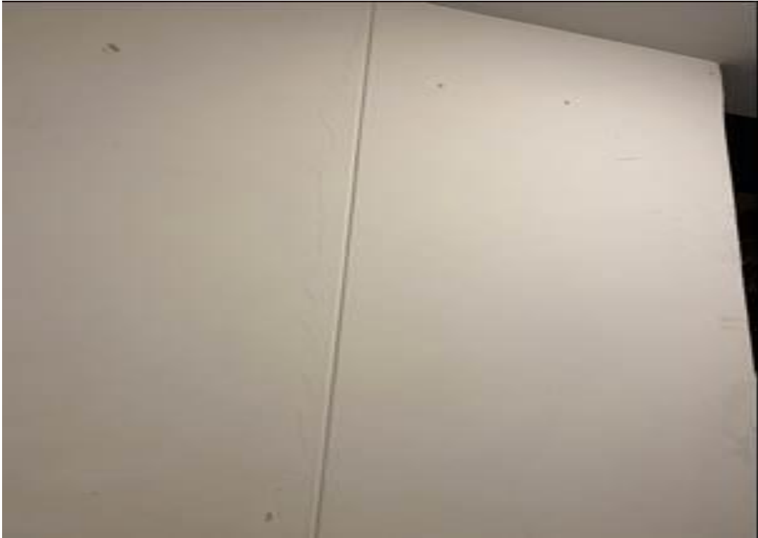
Foto 14 Fisuras en zona común torre 4 y 5 piso 12 a 2
