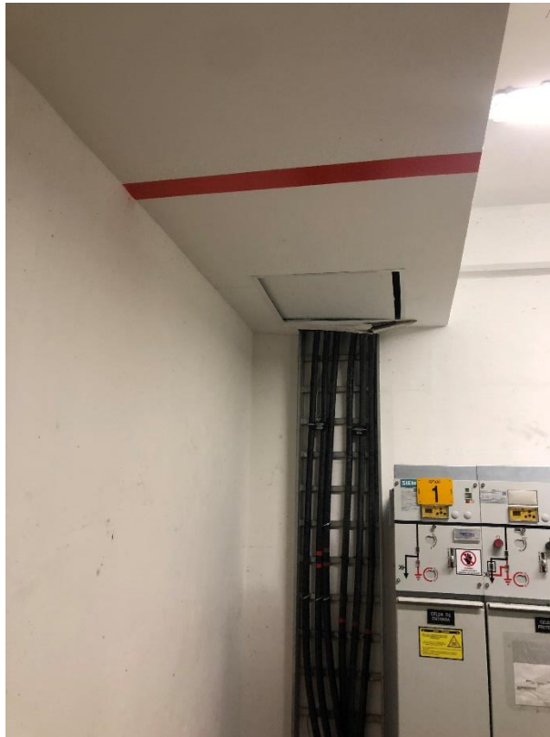
Foto 68. Cielo raso- Tapa de inspección
