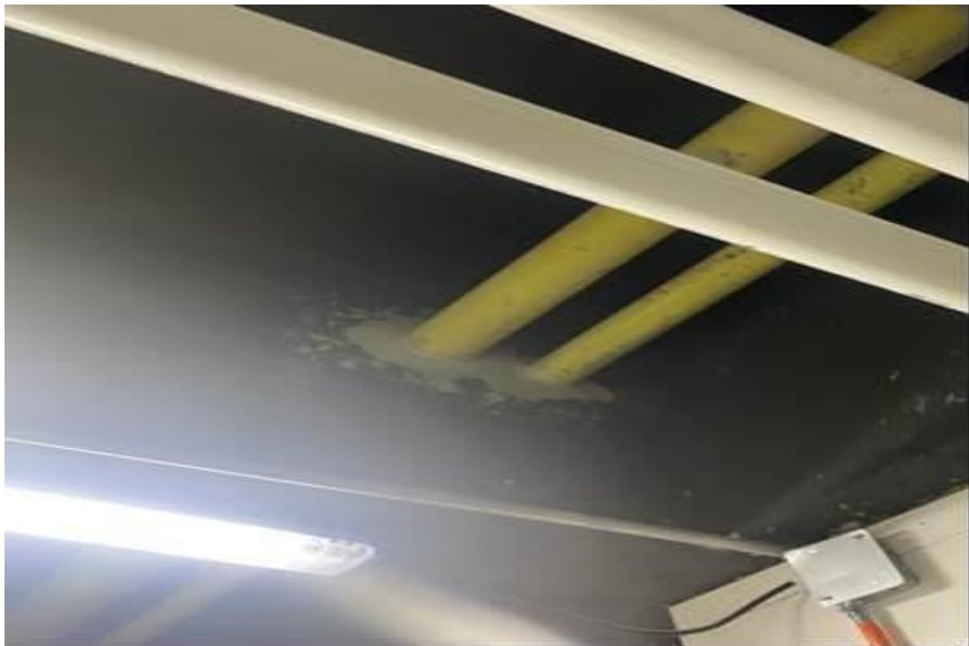
Foto 55 Pases en viga cercanos al nudo cuarto de basuras torre 3
