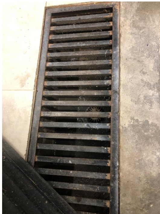
Foto 61. Cuarto de basuras de la torre 5, con rejilla en el sifón
