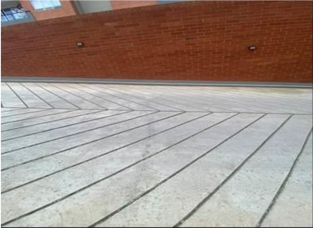
Foto 48 rampa acceso parqueadero con múltiples fisuras
