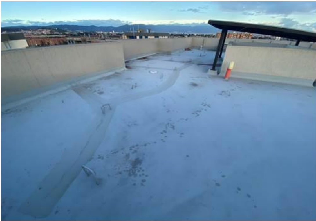
Foto 64 fisuras en placa cubiertas ya reparadas
