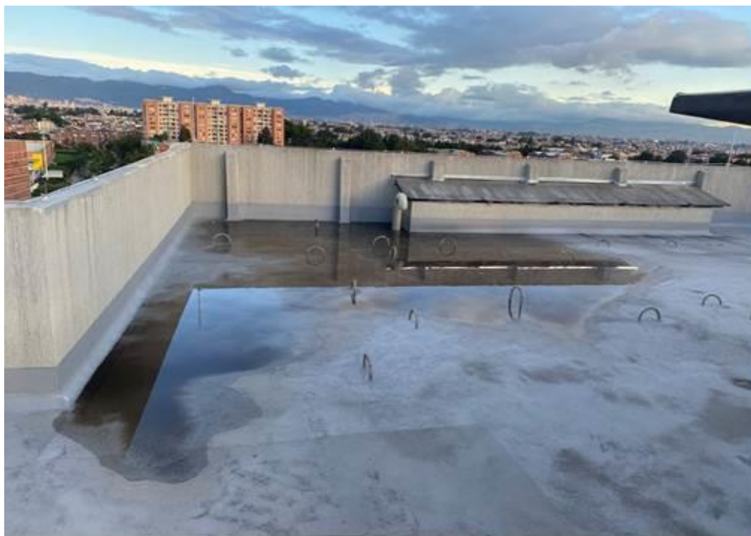
Foto 74 Empozamiento cubierta torre 4
