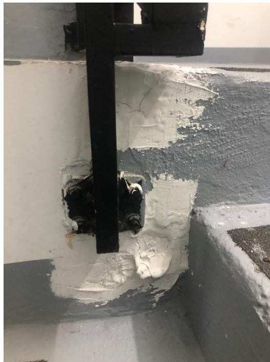
Foto 132. Rematar escalón contra baranda en la planta 2
