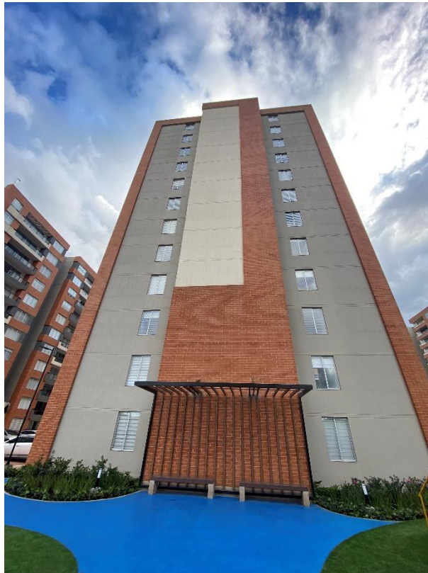
Foto 187. Fachada lateral torre 3
