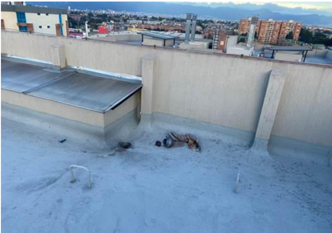
Foto 67 Cubierta torres sin rejillas en tragantes
