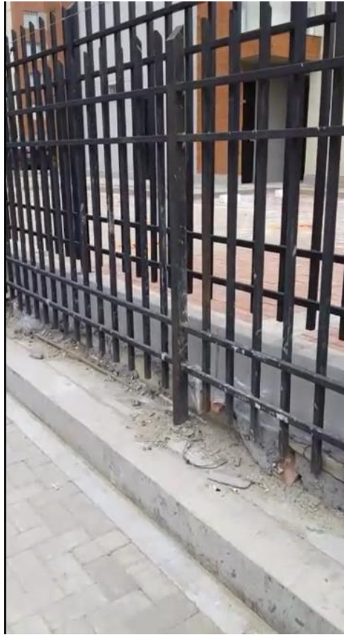
Imagen Fuente Administración 1. Cerramiento colindante a nuevo proyecto norte
