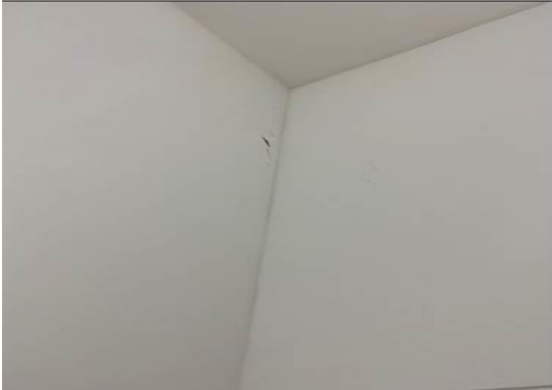
Foto 8 Fisuras en escalera emergencia torre 2 piso 12 a piso 10
