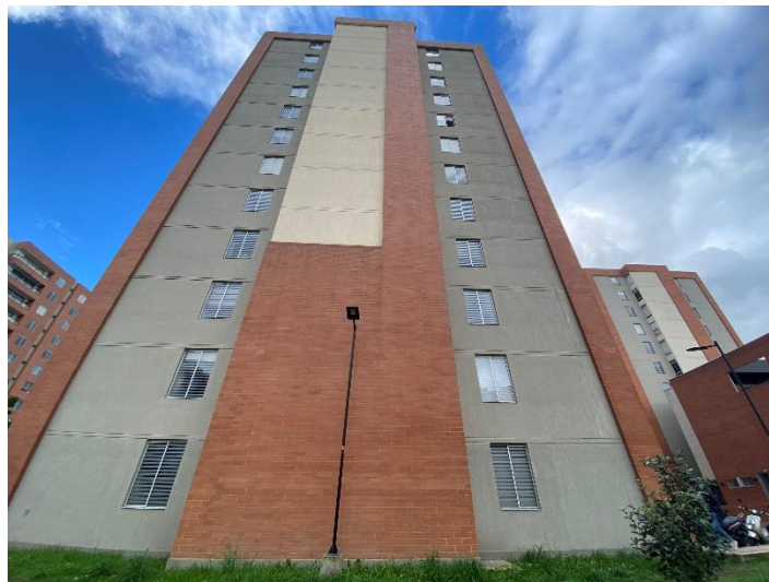
Foto 186. Fachada lateral torre 1
