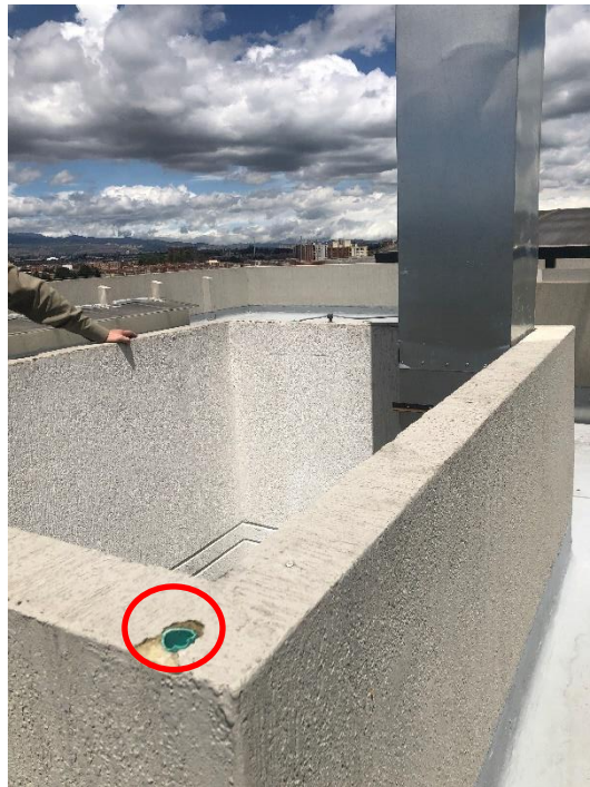
Foto 111. Sellar tubería
