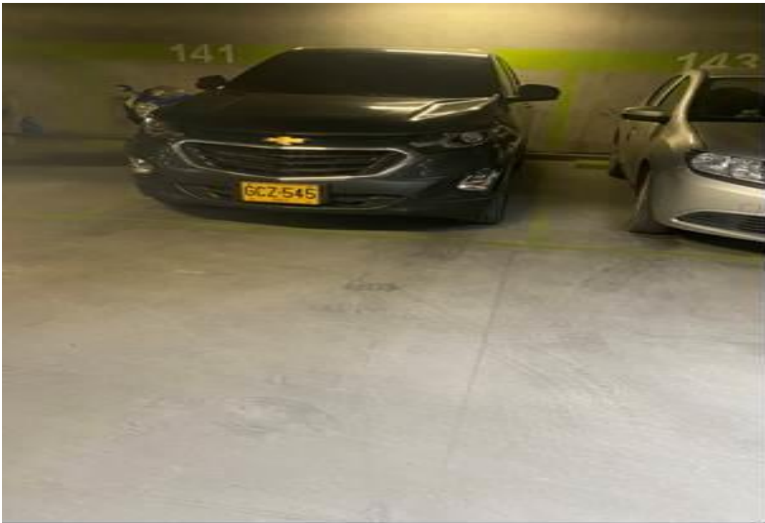
Foto 38 Fisura en placa de contrapiso frente parqueadero 141
