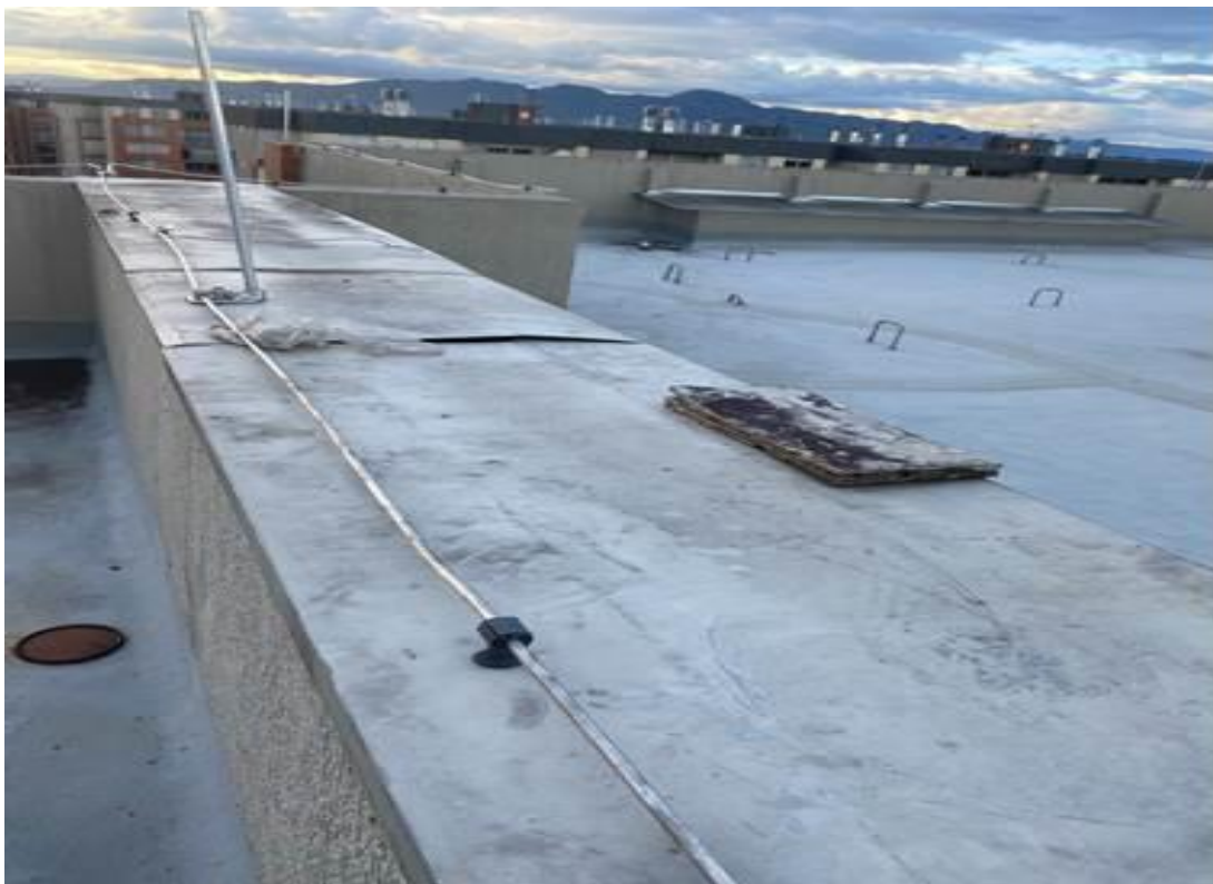
Foto 84 Marquesina perimetral y residuos de construcción en cubierta torres 2 y 3
