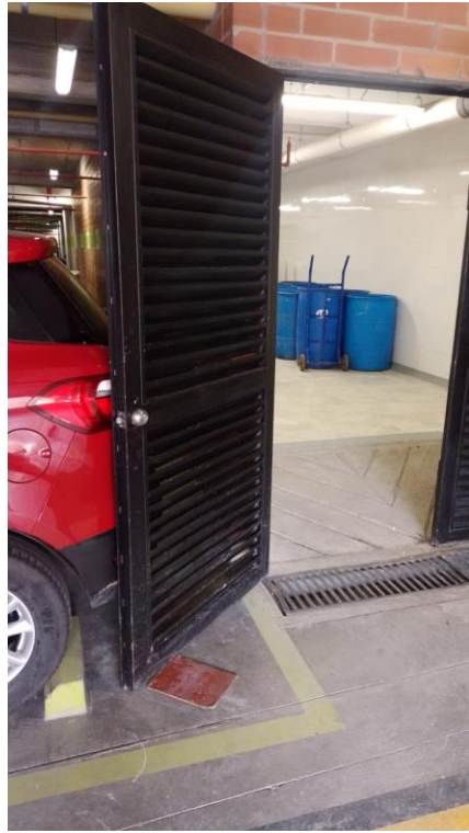
Foto 64. Cuarto de basuras principal
