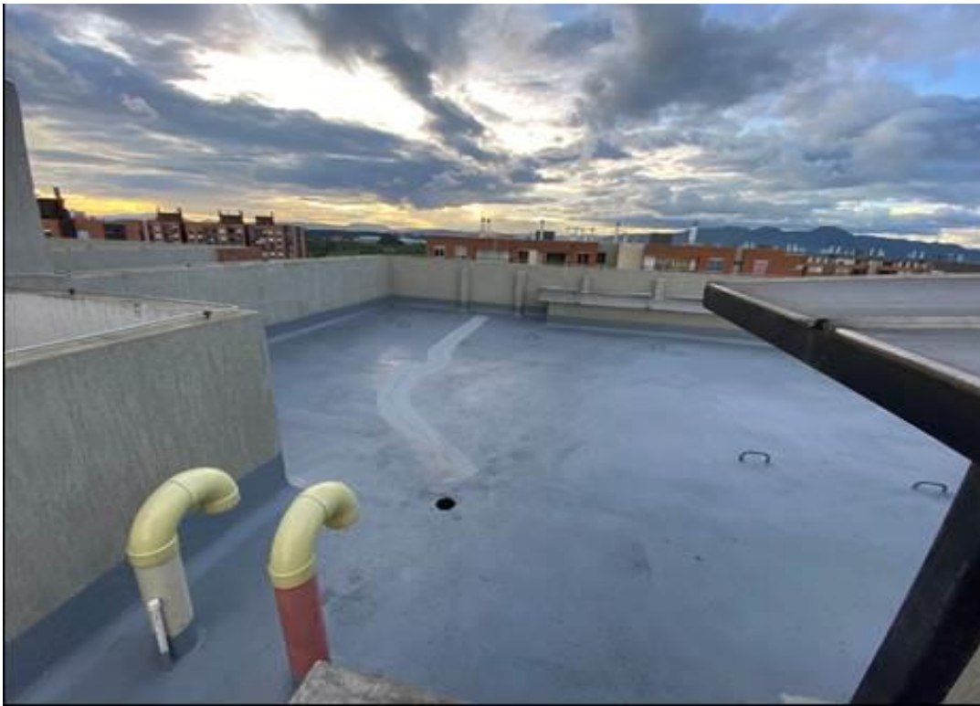
Foto 63 Fisuras reparadas en cubierta.
