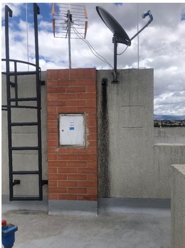
Foto 160. desagüe de cubierta de ascensor
