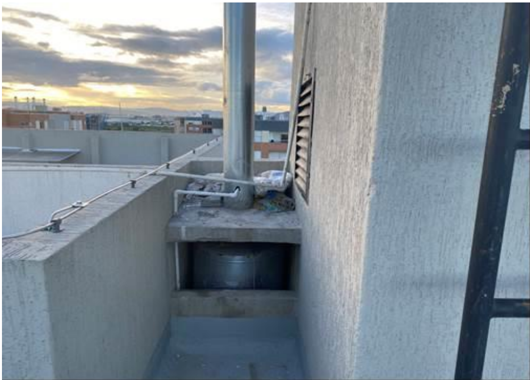
Foto 81 Empozamiento torre 2 y ducto sin rematar
