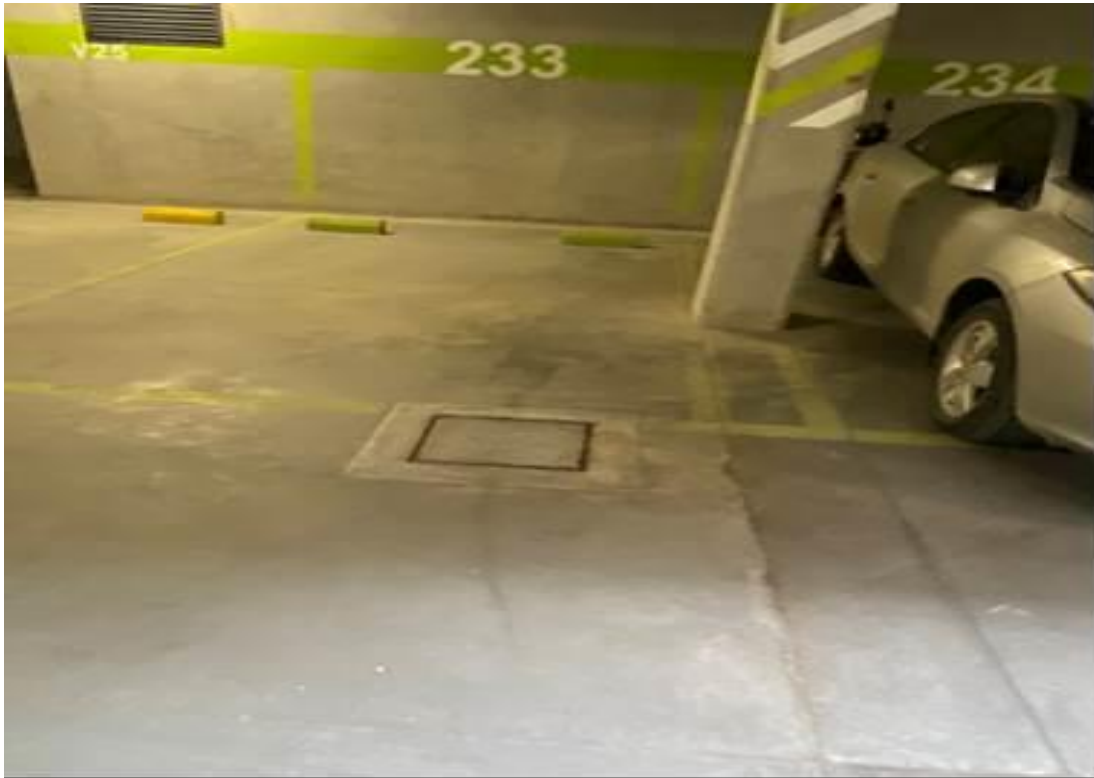
Foto 33 Fisura en placa de contrapiso parqueadero 233
