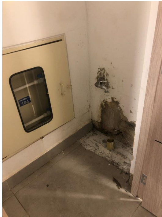
Foto 102. poceta de agua en construcción
