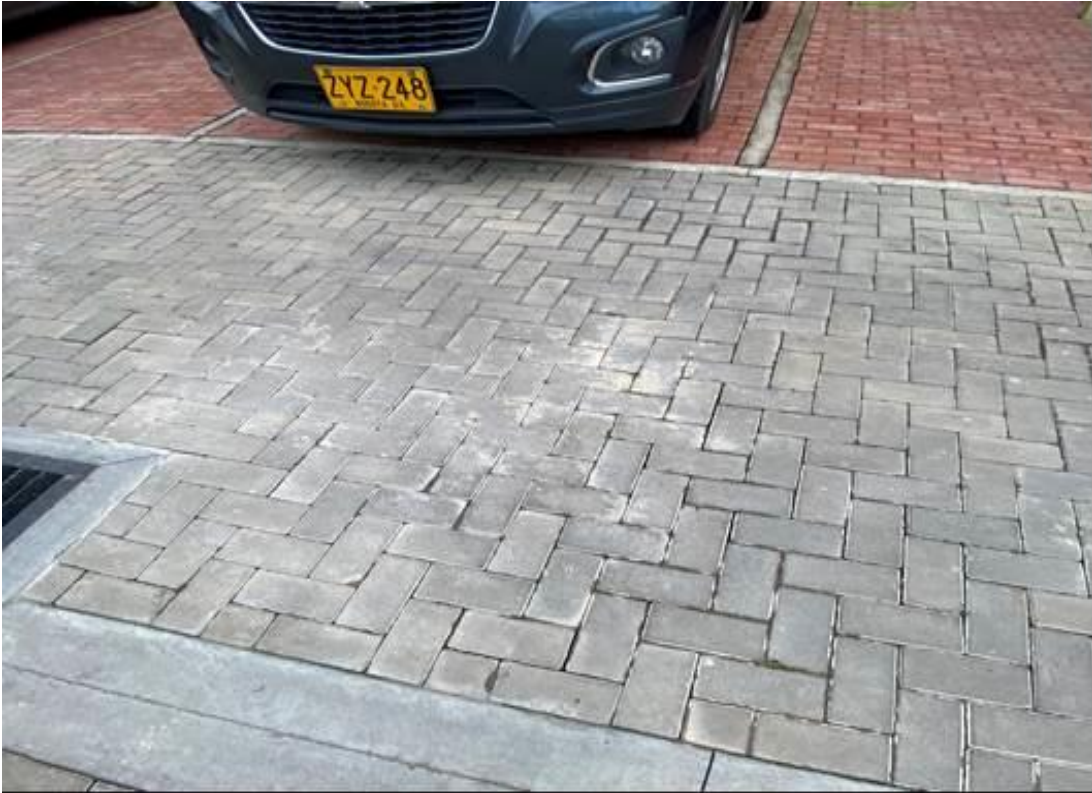
Foto 45 Adoquín este presentado deterioro prematuro
