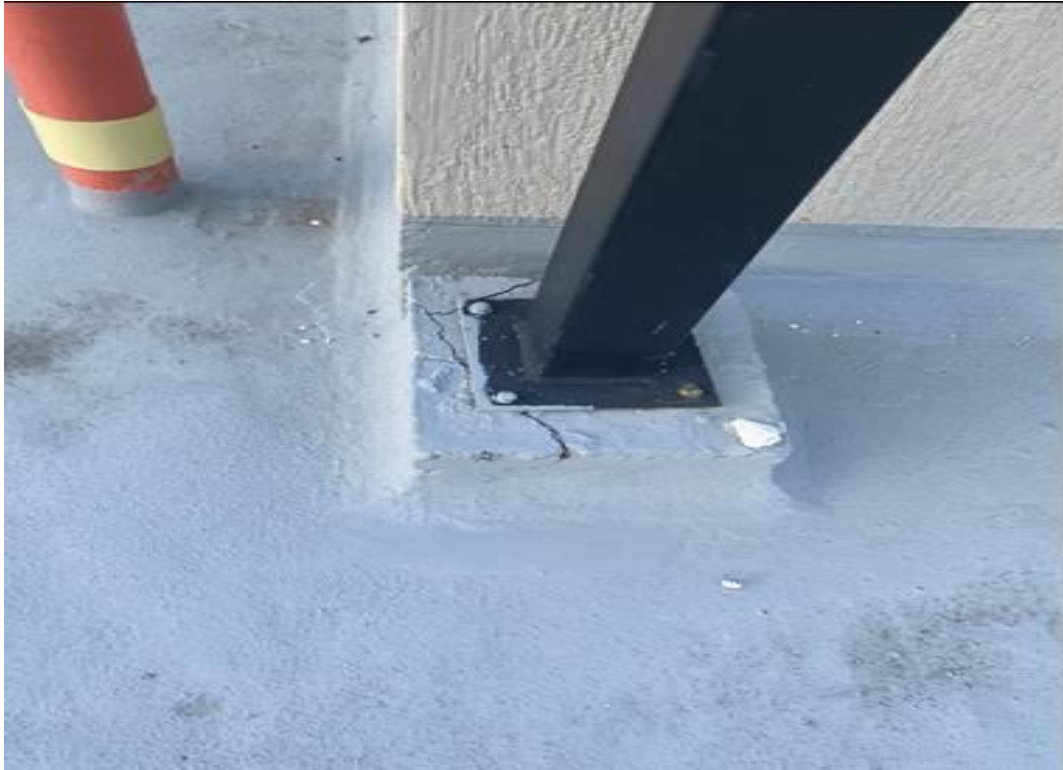
Foto 61 pedestal cubierta liviana torre 2 fisurado
