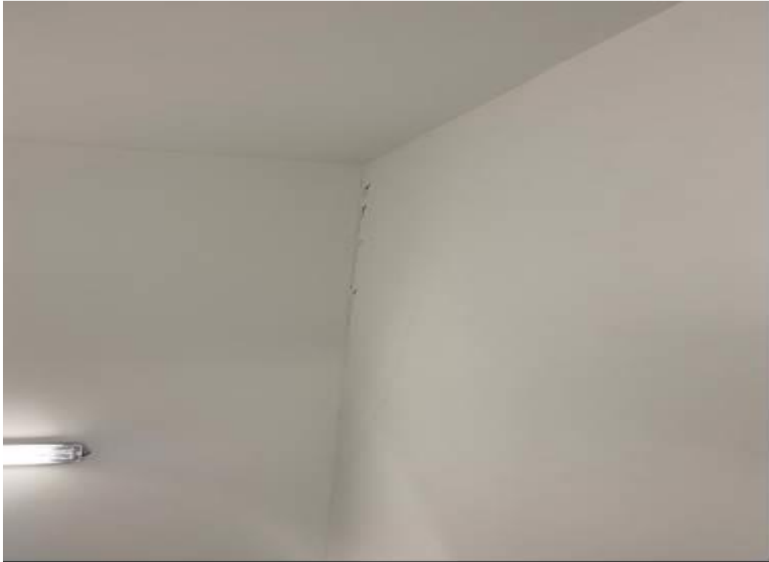
Foto 17 Fisuras en escalera emergencia torre 4 y 5 piso 12 a 2
