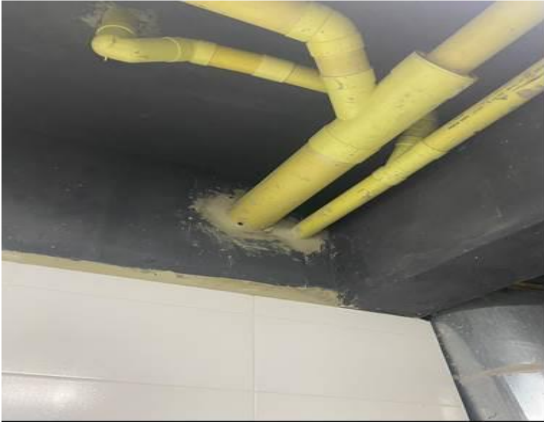
Foto 55 Pases en viga cercanos al nudo cuarto de basuras torre 3
