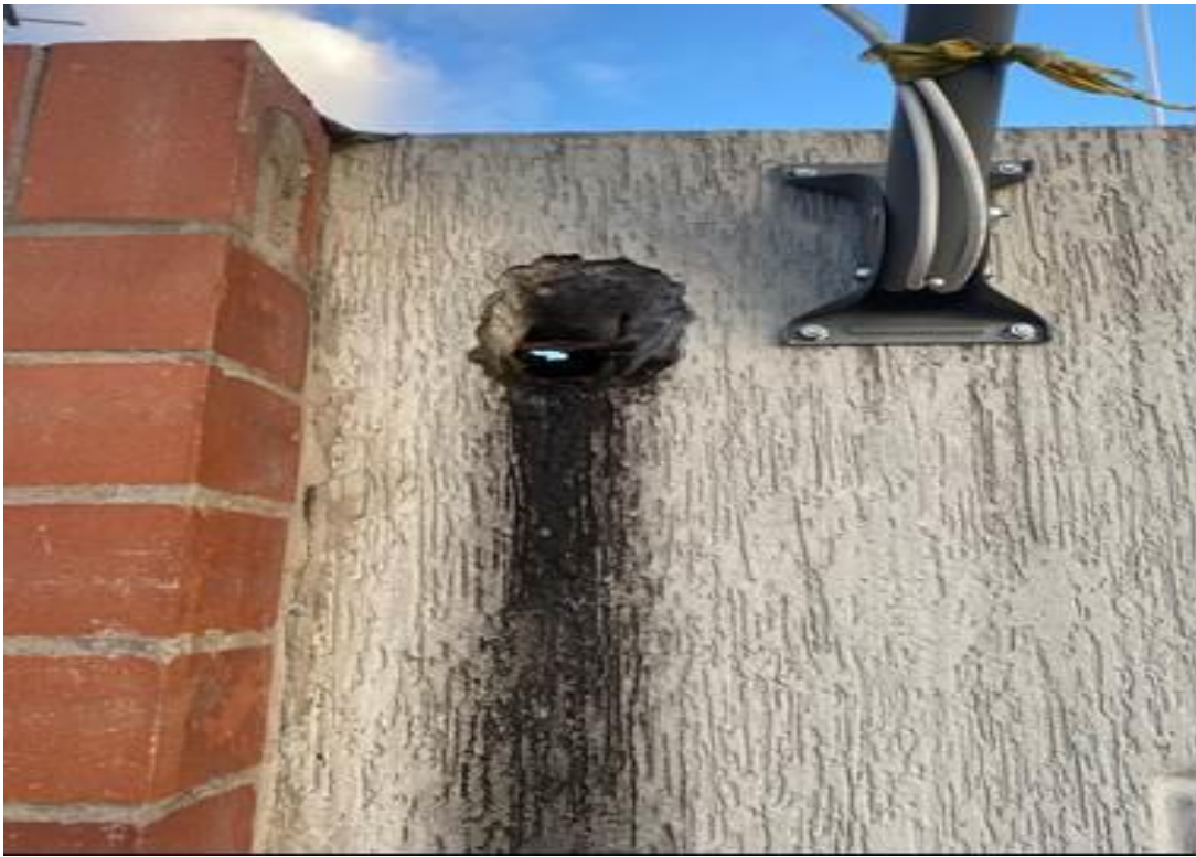
Foto 71 Hueco cubierta maquinas torre 4
