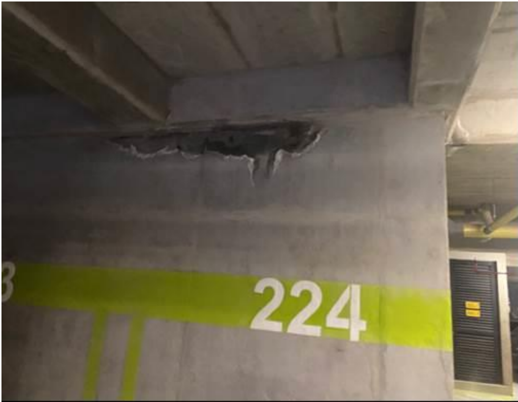
Foto 20 Filtraciones por fisuras muro de contención sótano
