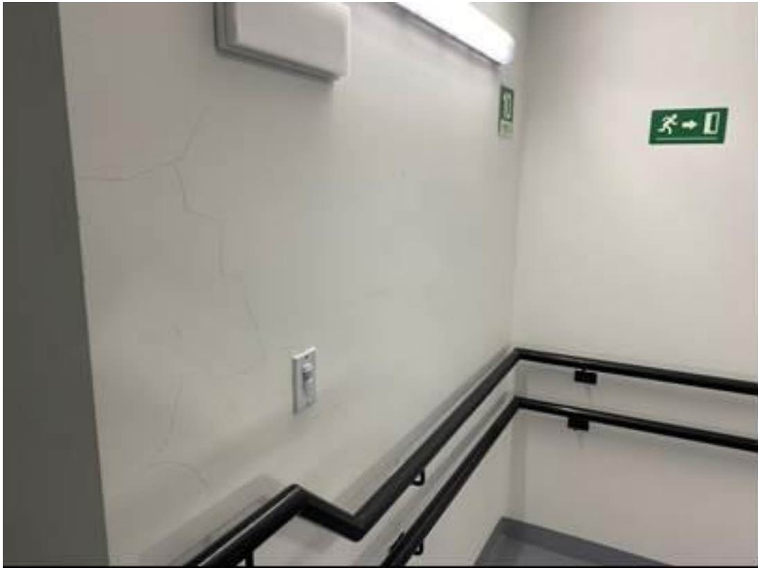
Foto 5 Fisuras en escalera emergencia torre 1 piso 12 a piso 1
