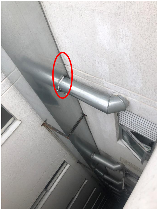
Foto 162. Remate de ducto
