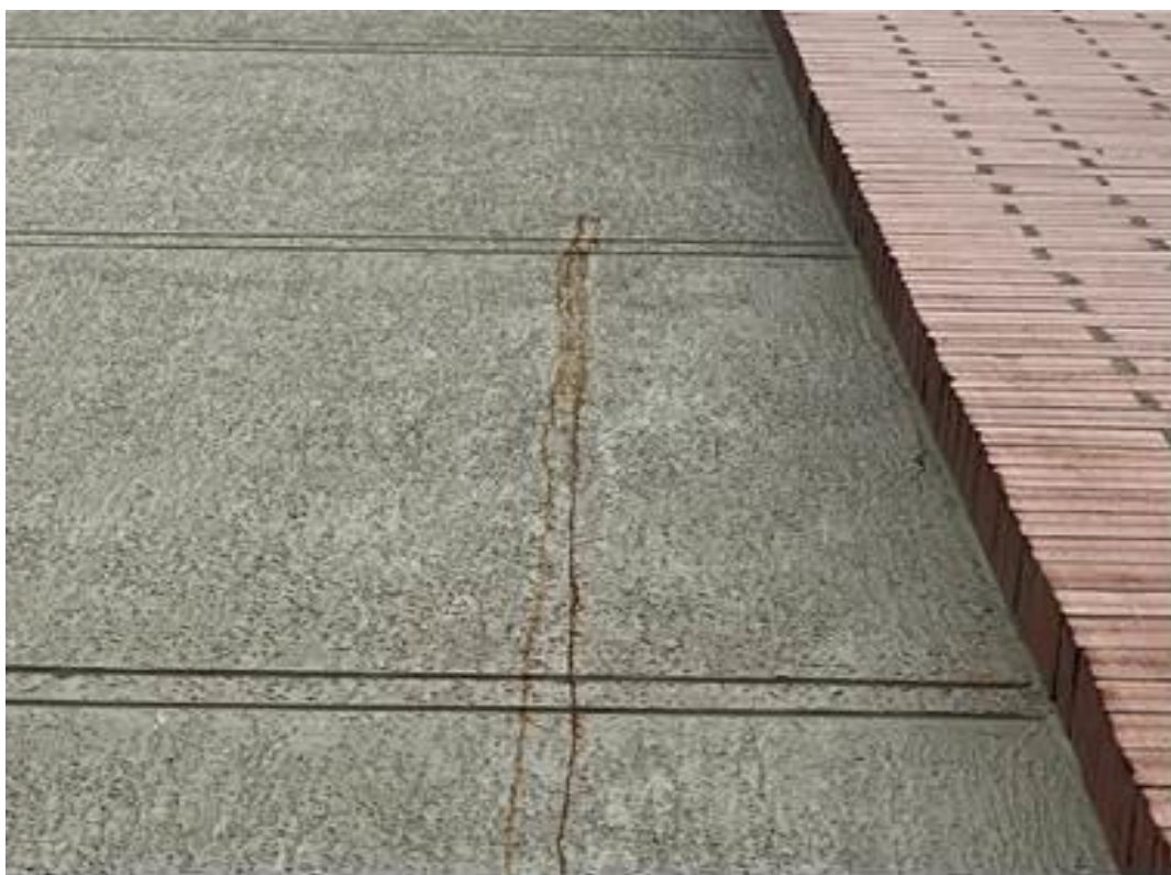
Foto 87 afectación en fachada torre 1 por acero expuesto
