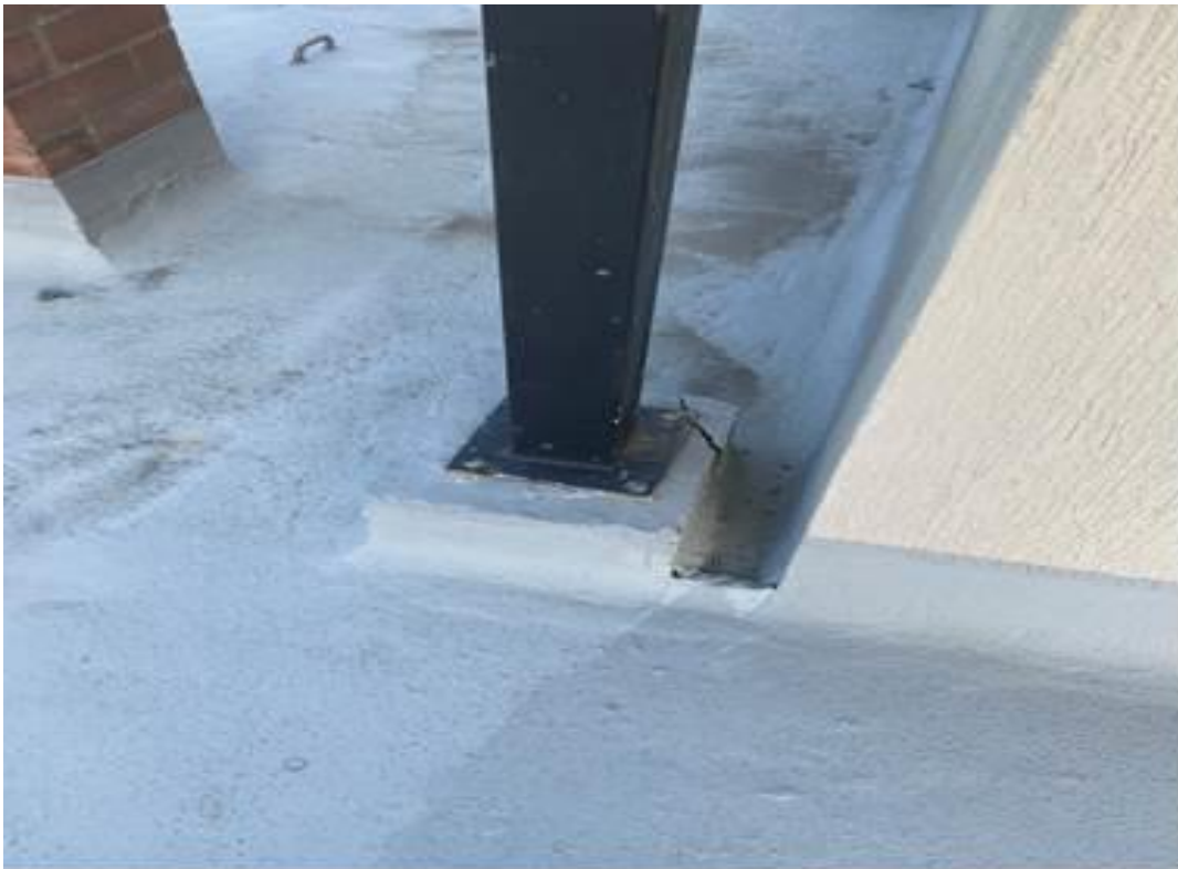
Foto 61 pedestal cubierta liviana torre 2 fisurado
