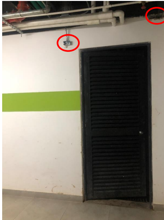
Foto 56 Cuarto de basuras Torre 2
