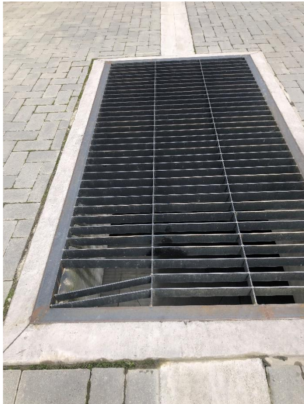
Foto 20 Rejilla de ventilación frente el parqueadero 96 y 15
