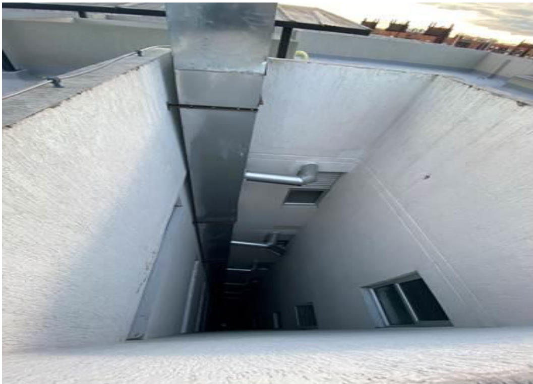
Foto 75 Ducto de extracciones de cubierta sin arriostrar y sin detalle en planos
