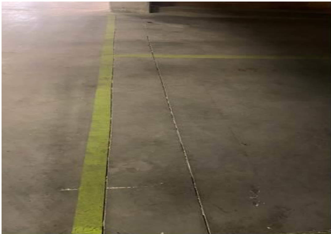
Foto 39 Fisura en placa de contrapiso frente parqueadero 149
