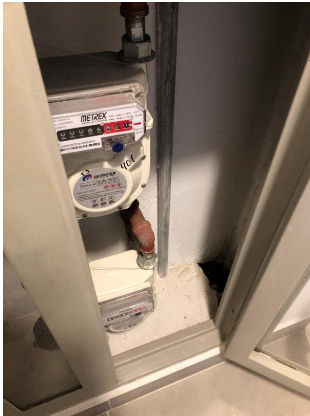
Foto 130. Rematar al interior de los gabinetes de medidores de gas
