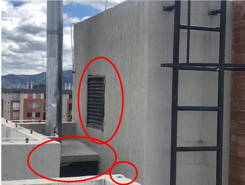
Foto 110, remates de muros contra rejillas
