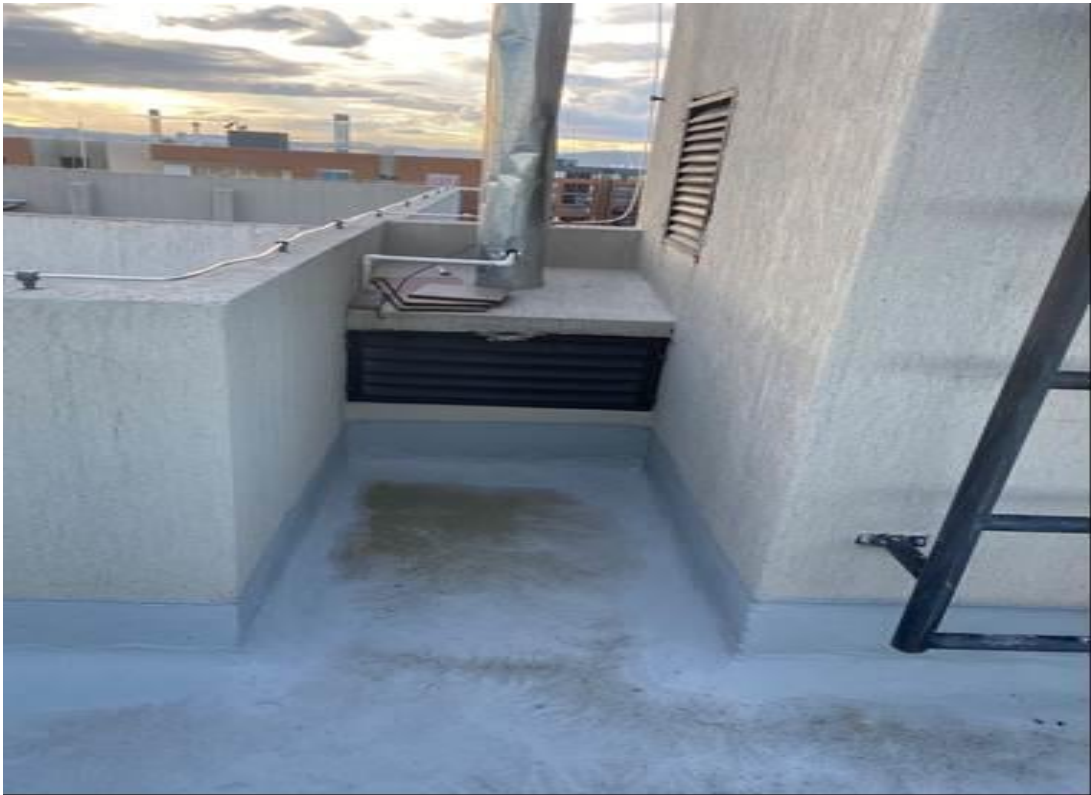
Foto 81 Empozamiento torre 2 y ducto sin rematar
