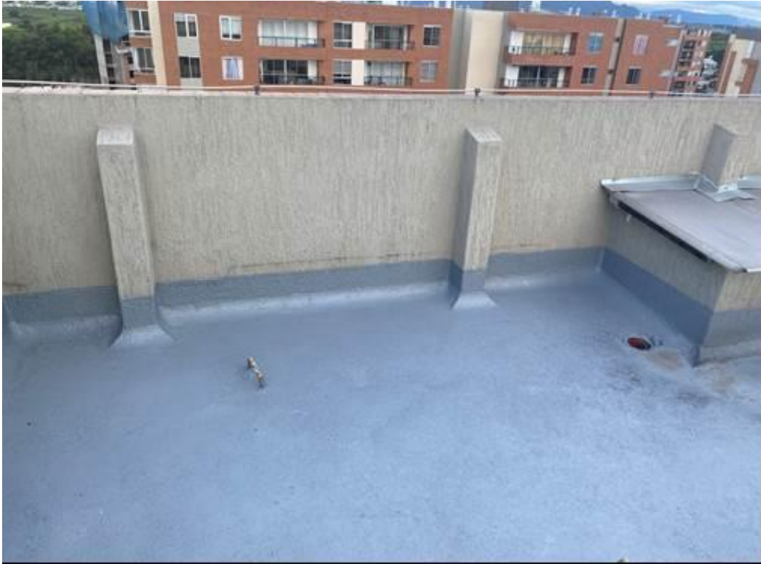
Foto 67 Cubierta torres sin rejillas en tragantes
