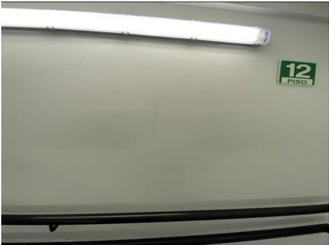
Foto 2 Fisuras en escalera emergencia torre 1 piso 12 a piso 1
