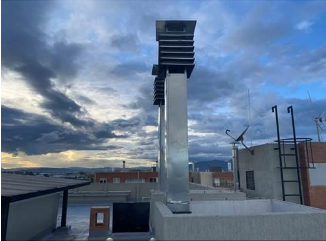
Foto 75 Ducto de extracciones de cubierta sin arriostrar y sin detalle en planos
