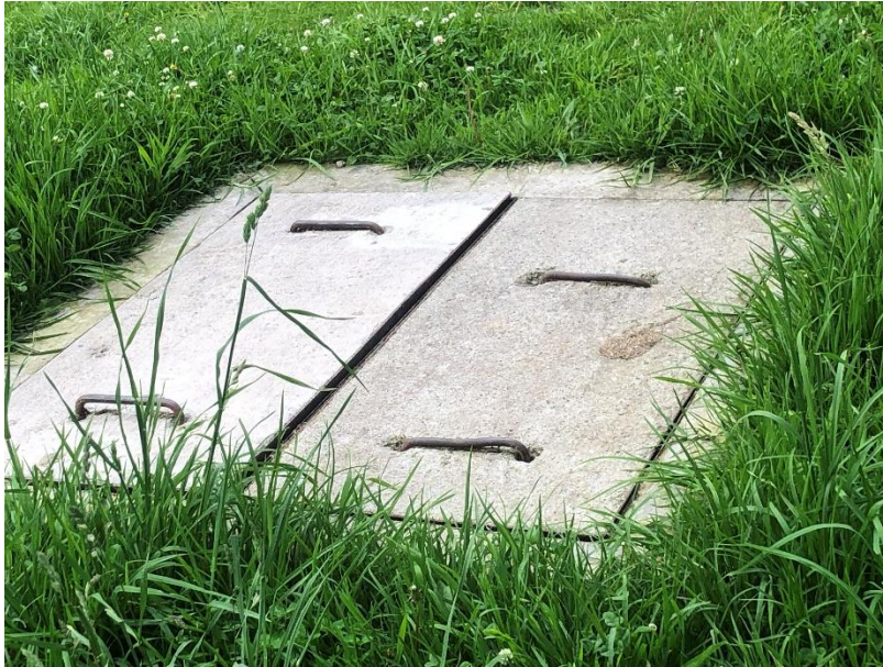
Foto 16. Tapa no asienta correctamente sobre la caja y la manija no baja
