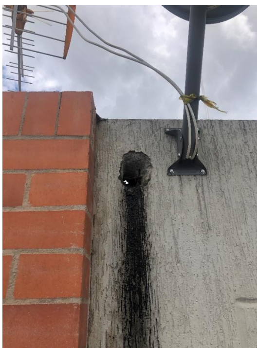
Foto 161. Desagüe cubierta de ascensor
