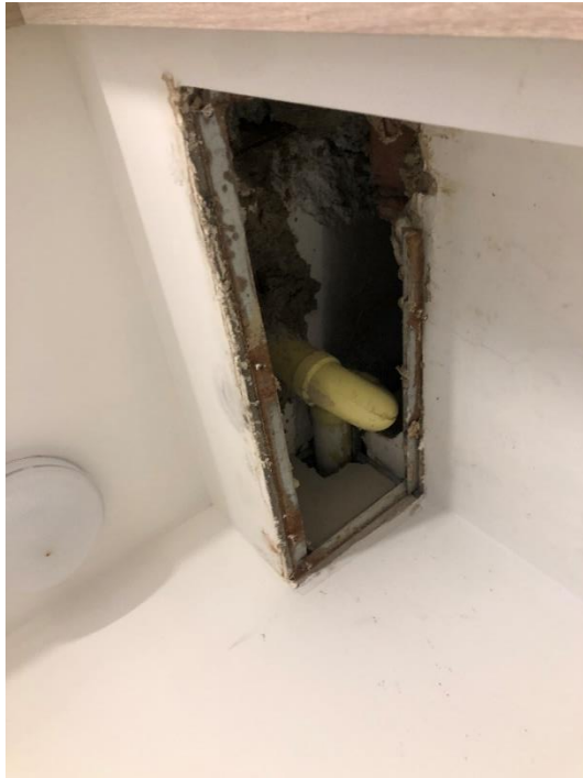
Foto 172. Tapar hueco cuarto de medidores apto703
