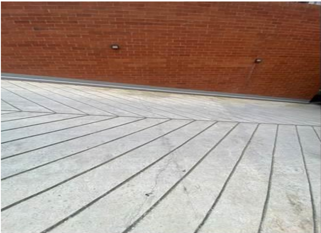
Foto 48 rampa acceso parqueadero con múltiples fisuras
