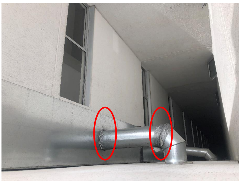
Foto 163. Remate de ducto
