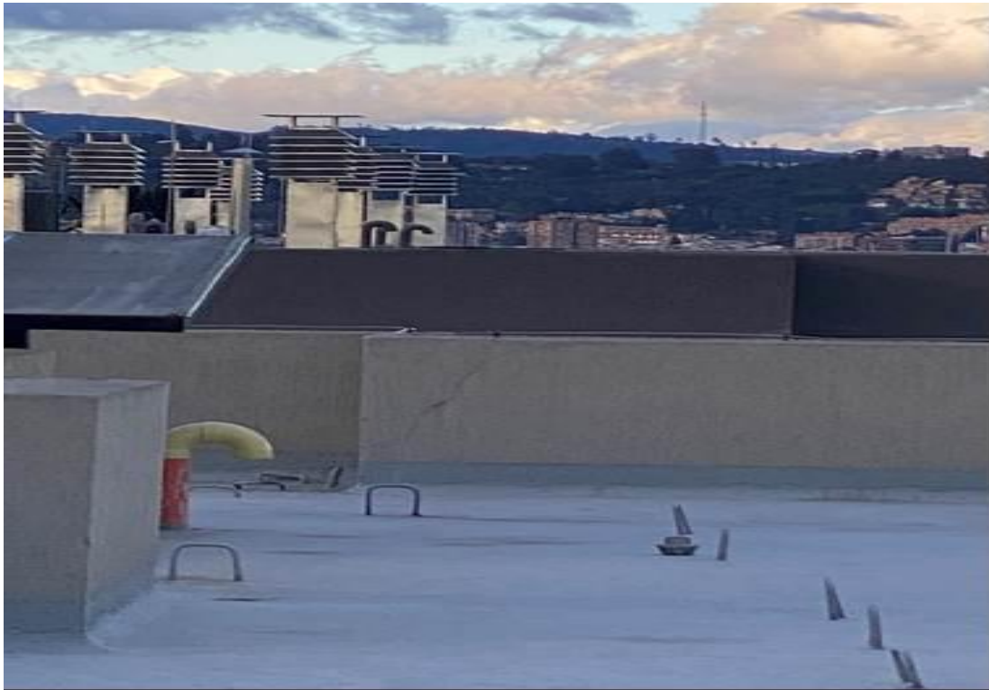
Foto 58 Antepecho torre 3 con fisura
