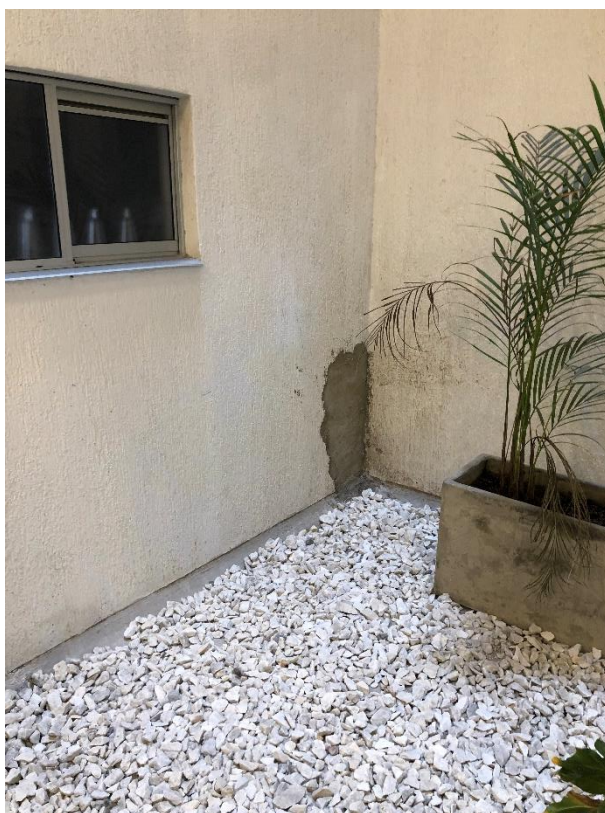
Foto 155. Rematar pared en vacío apto 101
