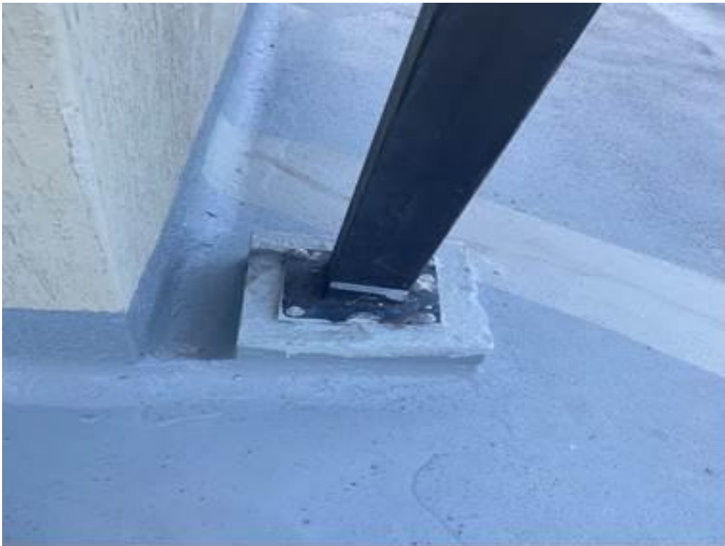
Foto 58 Antepecho torre 3 con fisura
