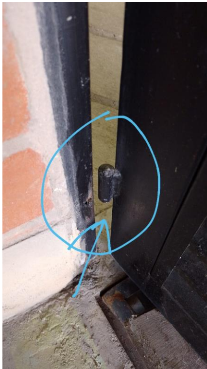
Foto 65. Bisagra suelta en el parte inferior cuarto de basuras pp
