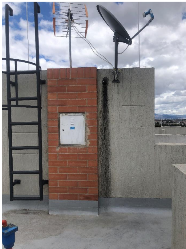
Foto 160. desagüe de cubierta de ascensor
