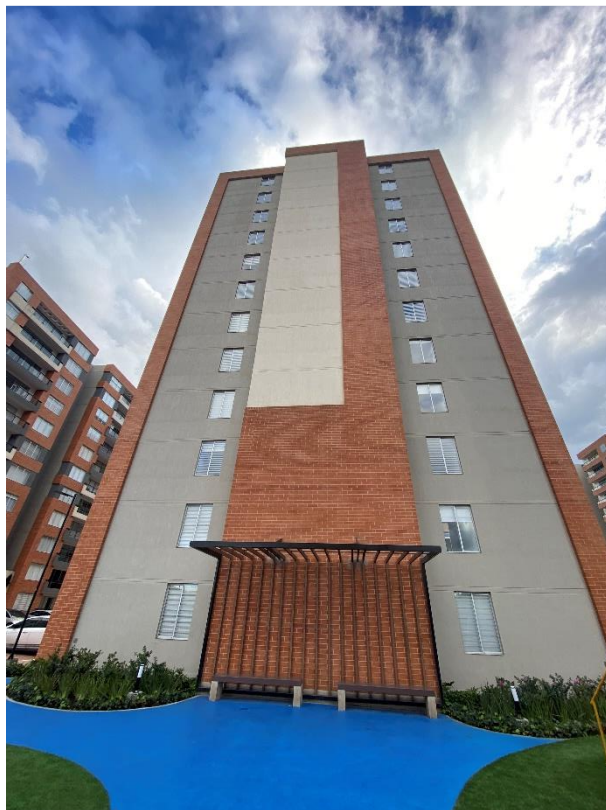
Foto 187. Fachada lateral torre 3
