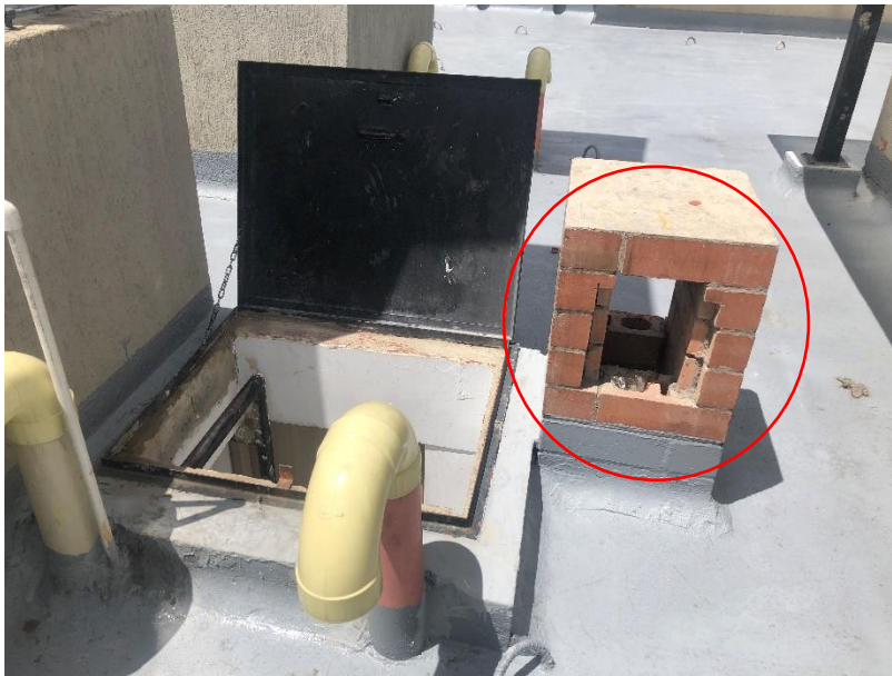
Foto 83.terminar acabados de muretes, falta rejilla
