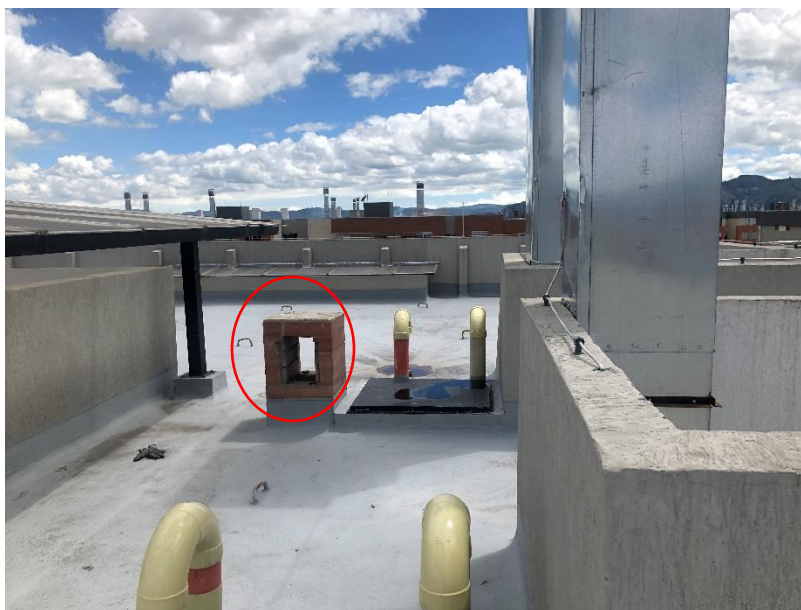
Foto 107. rematar muertes e instalar rejilla
