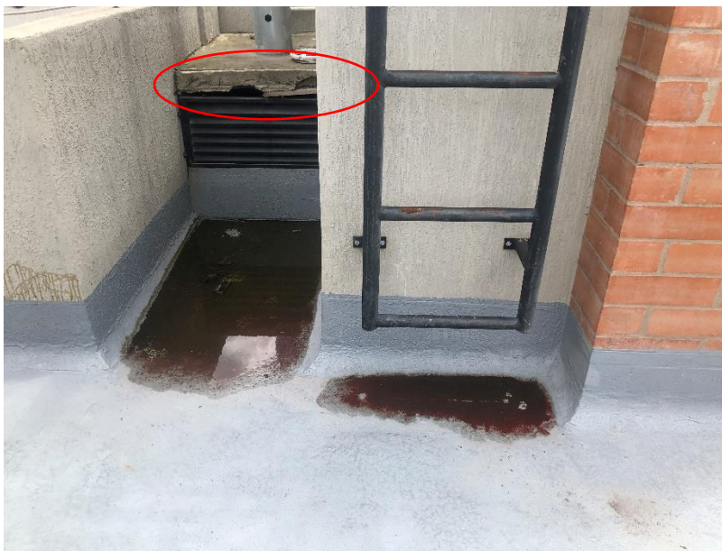
Foto 80. empozamiento de agua y mal acabado contra rejillas
