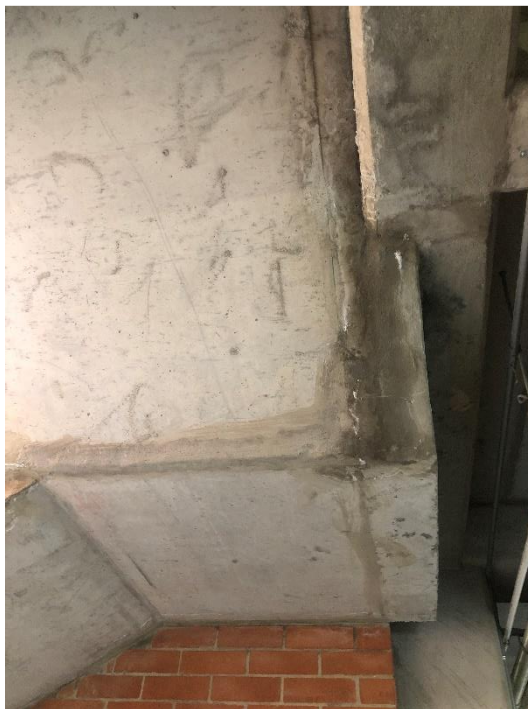
Foto 42. Humedad en la placa de techo de las escaleras frente a torre 2
