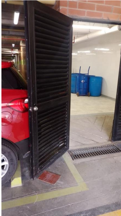
Foto 64. Cuarto de basuras principal
