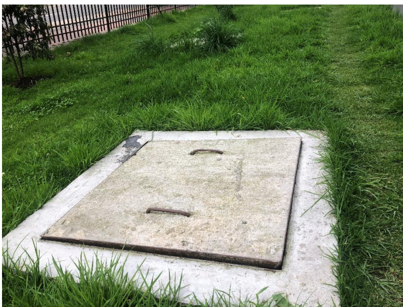
Foto 17. tapa no encaja en la caja y las manijas no bajan correctamente
