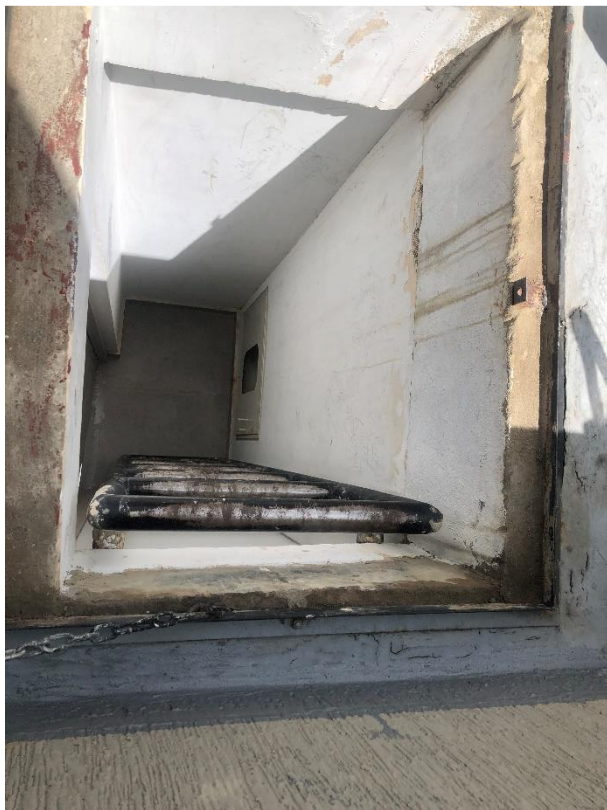
Foto 84. verificar filtraciones por claraboya
