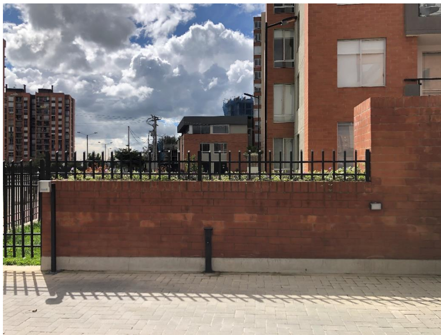
Foto 27. Madera con humedad
