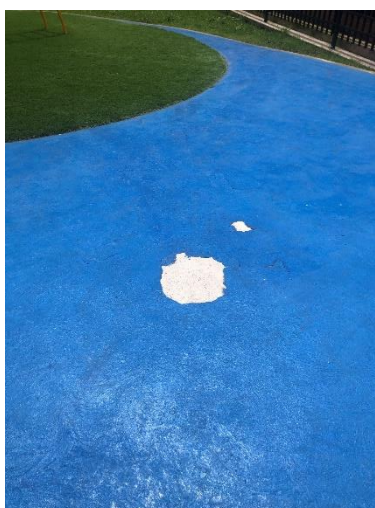
Foto 29. Levantamiento de acabado de piso
