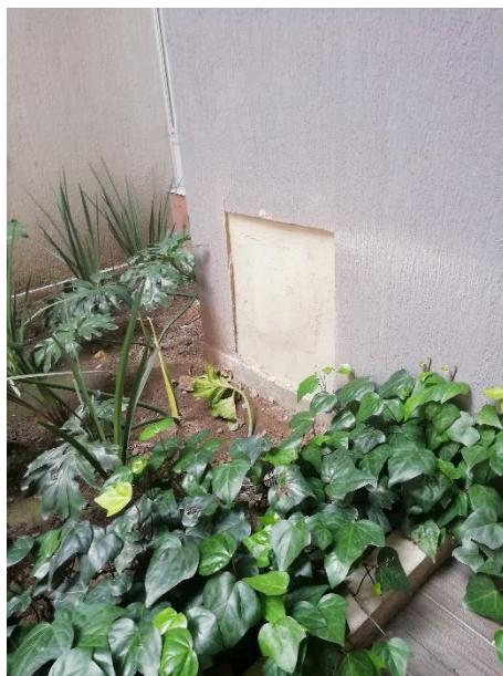
Foto 23. fachada sin rematar
