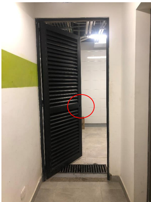
Foto 60. Cuarto de basuras torre 4 sin señalización ni cerradura
