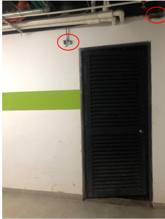
Foto 56 Cuarto de basuras Torre 2
