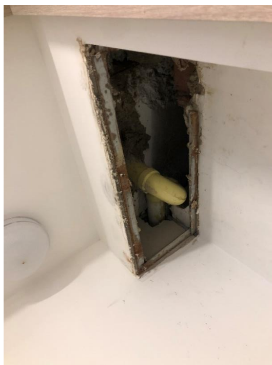
Foto 172. Tapar hueco cuarto de medidores apto703
