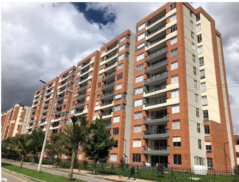
Foto 185. Fachada posterior torre 1-2-3
