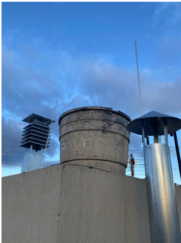
Foto 126. tanque de agua sobre cubierta del ascensor
