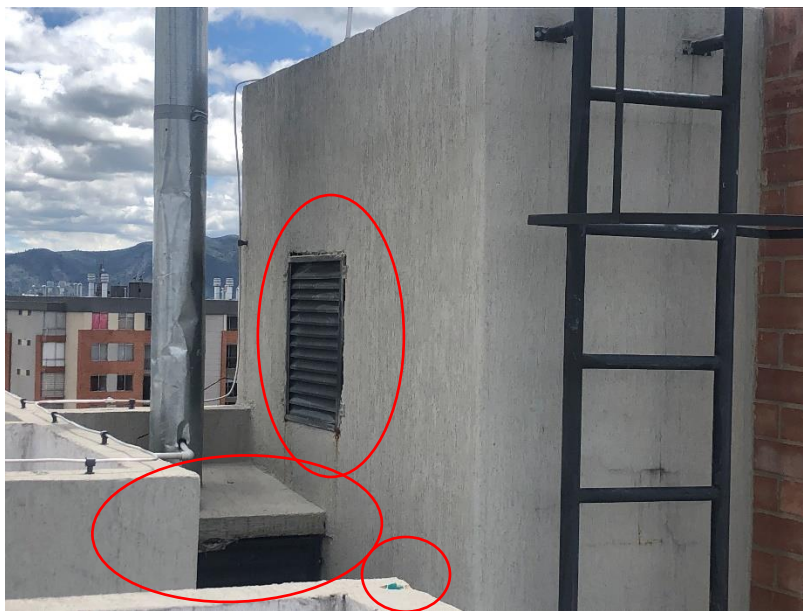
Foto 110, remates de muros contra rejillas
