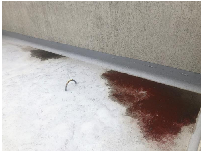
Foto 138. Empozamientos de Agua en cubierta
