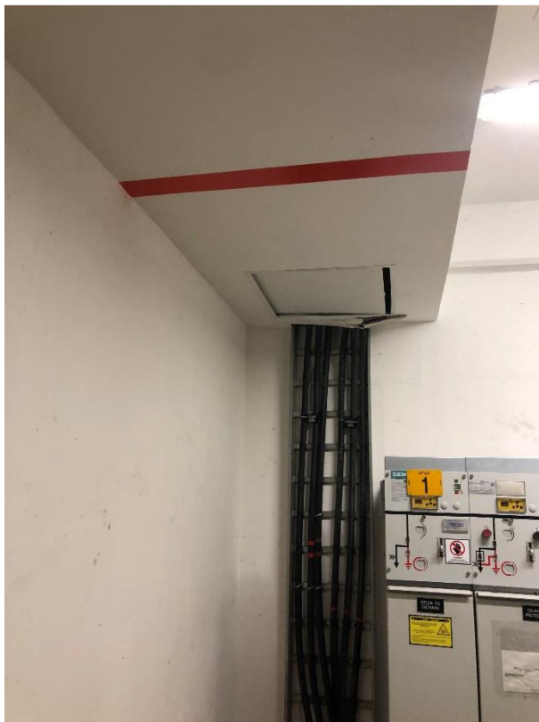
Foto 68. Cielo raso- Tapa de inspección
