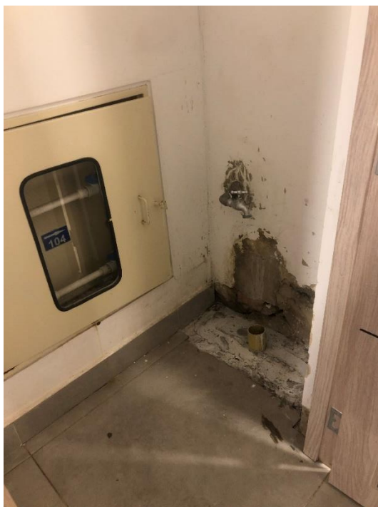
Foto 102. poceta de agua en construcción
