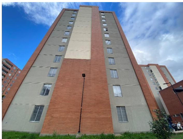
Foto 186. Fachada lateral torre 1
