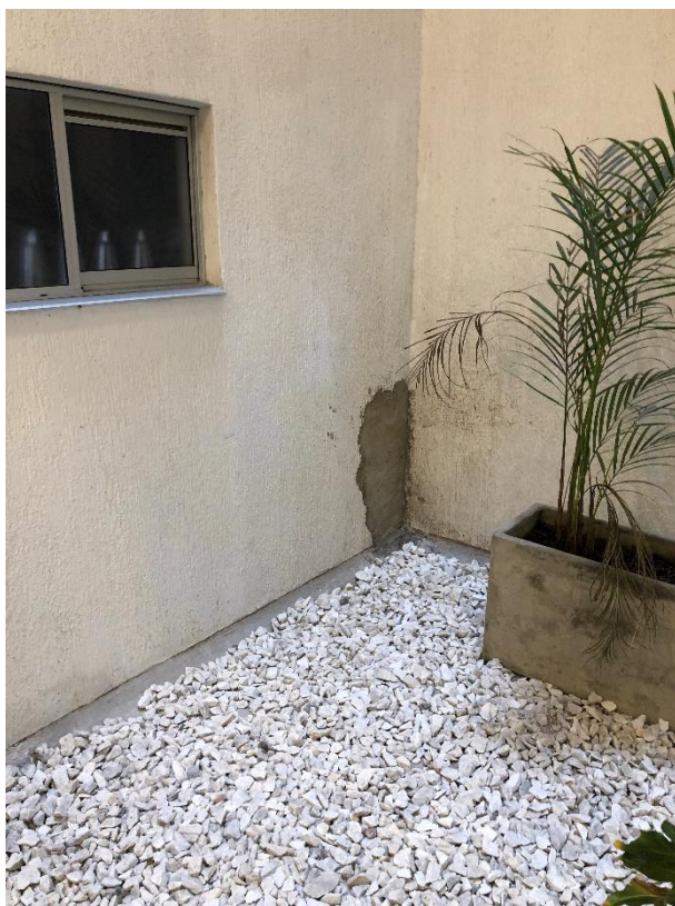
Foto 155. Rematar pared en vacío apto 101
