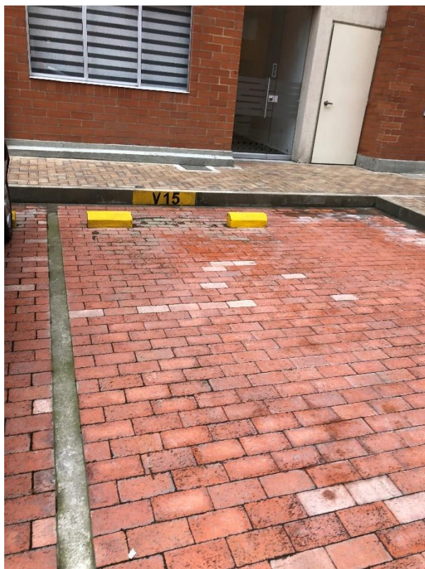
Foto 21. El parqueadero V-15 sin señalización PMR
