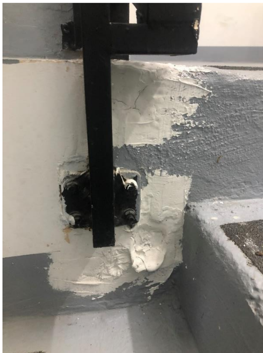
Foto 132. Rematar escalón contra baranda en la planta 2
