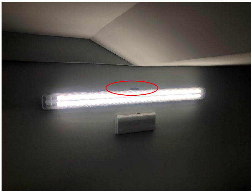
Foto 100. Rematar hueco en pared sobre lampara PLANTA 6
