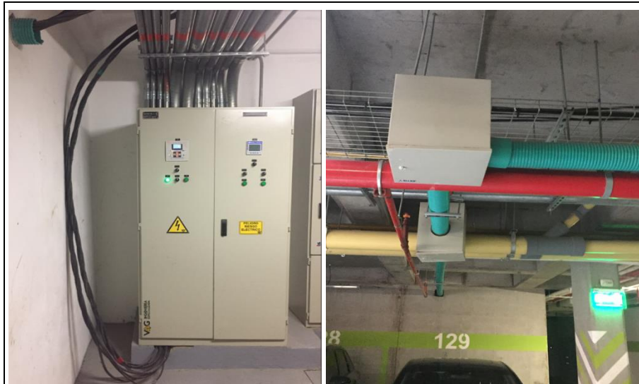
Fotografía 20. Acometida externa. Fuente propia.
